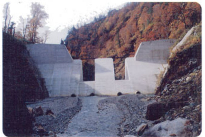
祖母谷第7号砂防堰堤
