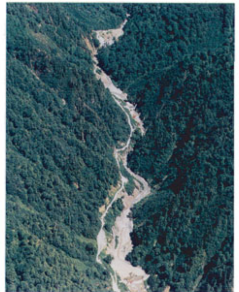
祖母谷砂防堰堤群
