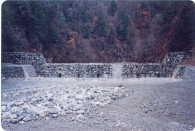
黒薙川第4号砂防堰堤
