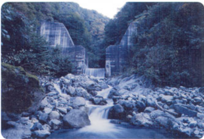
野坊瀬谷第3号砂防堰堤
