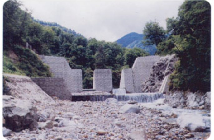
小黒部谷第1号砂防堰堤
