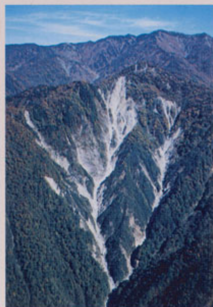
不帰谷崩壊地
