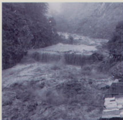
昭和44年8月11日 祖母谷下流砂防堰堤地点の土砂流出状況
