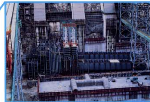
排砂設備据付状況
