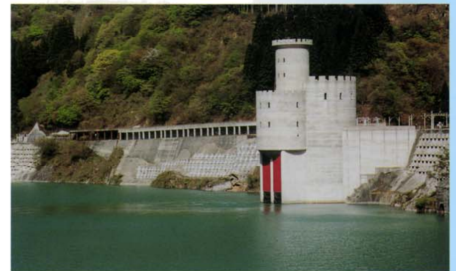
新柳河原発電所
