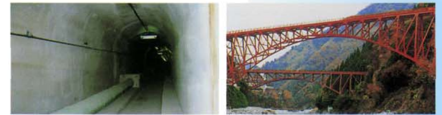
付替引湯管路
