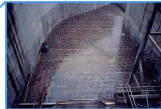
ライニング施工
