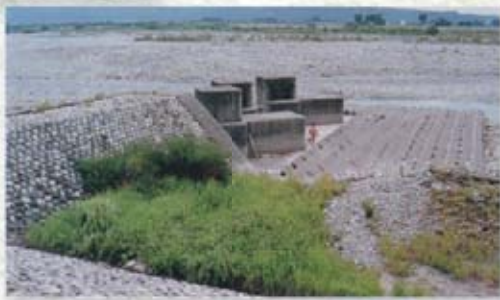
縦工は、水衝部における堤脚保護を目的とした工法。大型ブロックを組み合わせた構造物を、一定間隔で一定区間のみ施工する。
