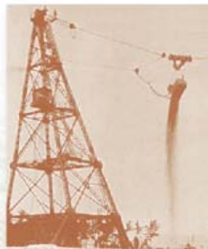
昭和26年から42年まで、天井対策としてタワーエクスカベータによる大規模な河床掘削が実施された。
