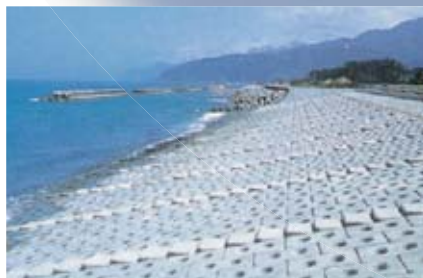
八幡地先の緩傾斜堤
