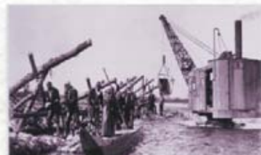
昭和12年、直轄事業初年の大布施堤の改修。蒸気ドラグラインによる掘削と、人力を主にした川倉の据え付けの様子。
