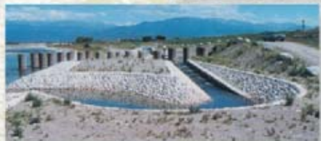
急流の威力から堤防や護岸工を守る巨大水制は、黒部川で開発された。写真はピストル型。
