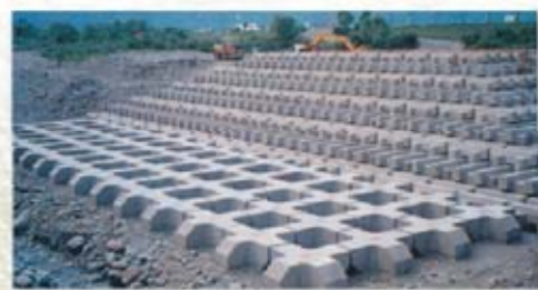
縦工は、水衝部における堤脚保護を目的とした工法。大型ブロックを組み合わせた構造物を、一定間隔で一定区間のみ施工する。
