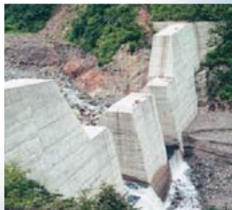
祖母谷第7号砂防えん堤
