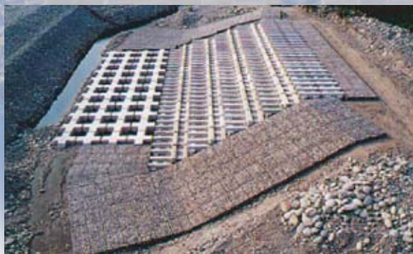
堤脚保護のための縦工
