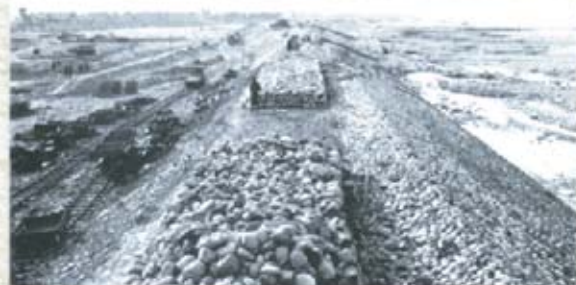
昭和12年、直轄事業初年の大布施堤の改修。蒸気ドラグラインによる掘削と、人力を主にした川倉の据え付けの様子。
