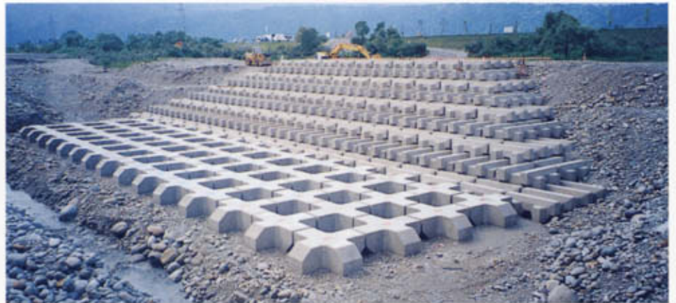
施工中の縦工
