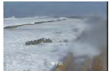
高波による越波 (神子沢 CCTV 映像 平成 20 年 2 月 24 日 11:10)
