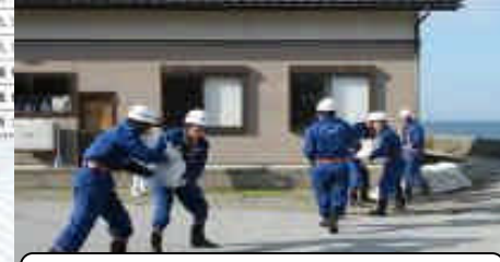
水防団による土のう積
