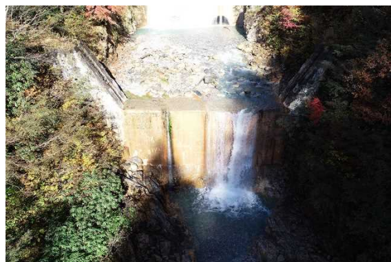
写真-2 UAV点検
