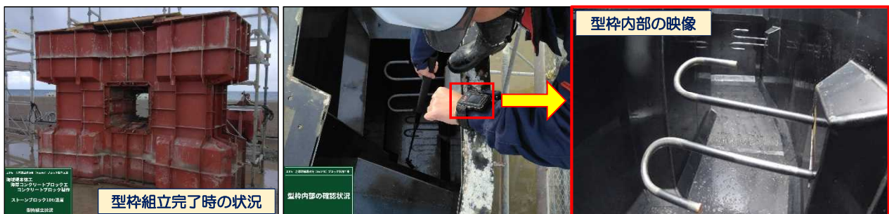
写真5. カメラを活用した型枠内部の確認状況
