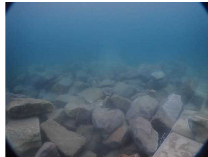
岩石投入状況（水中部）
