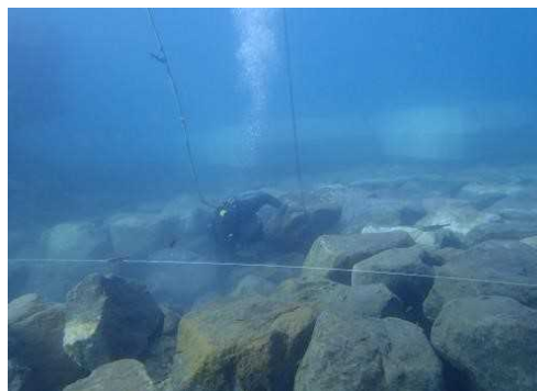
水中での捨石均し作業
