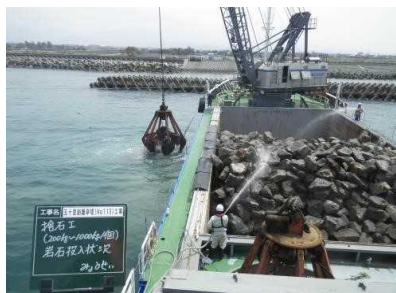
ガット船による岩石投入作業
