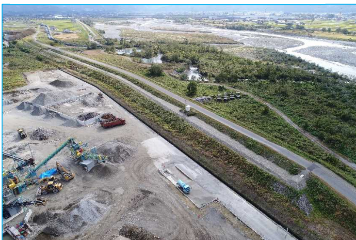
写真-9 完成写真(福島堤) ※図-7と比較
