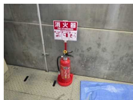
消火器設置 (塗料攪拌場所)
