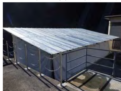
転向シーブ周辺防水設備
