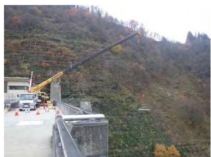
ラフタークレーン使用状況
