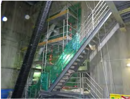
チューブライト設置(左岸側戸当り)
