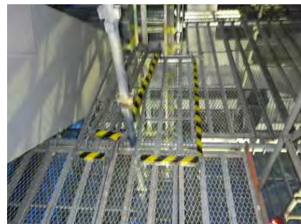
足場板段差部をトラテープで明示 写真5 つまづき転倒・転落防止対策
