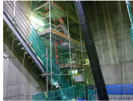
チューブライト設置(右岸側戸当り)
