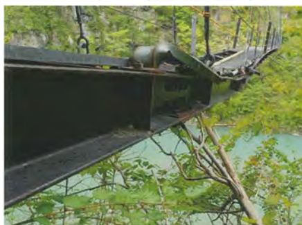
写真7 桁座屈
