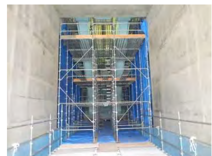
塗装塗替用足場
