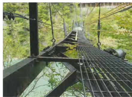
写真8 グレーチング破損
