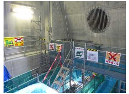
渡り通路設置
