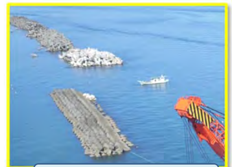
【大型起重機船による本体ブロック据付】
