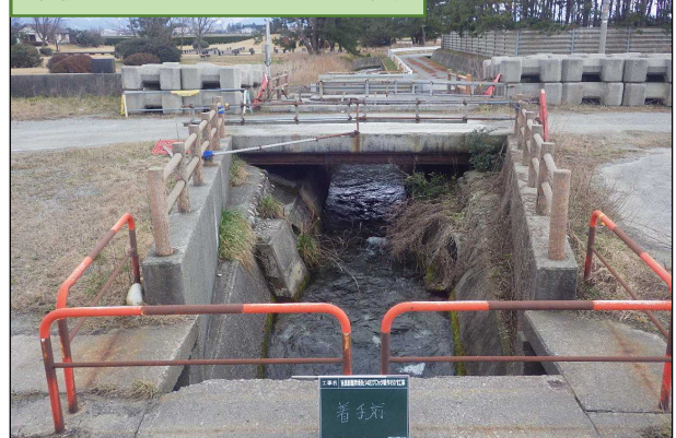
門形カルバート 施工前写真
