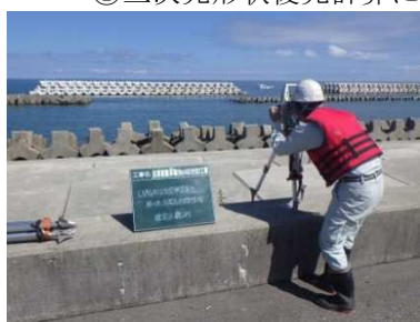
標定点の設置
