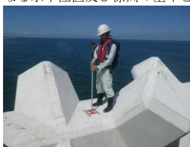
標定点の設置
