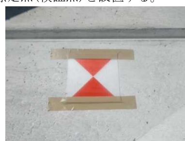
標定点の設置
