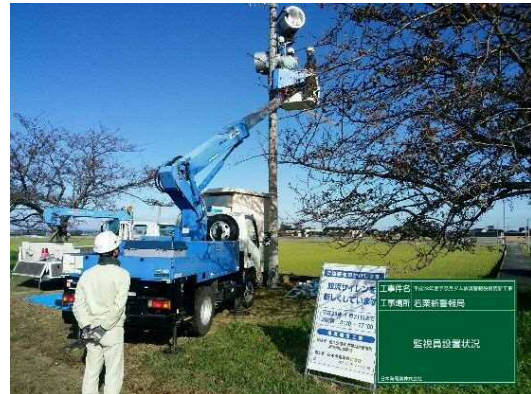
【写真9 監視員設置状況】
