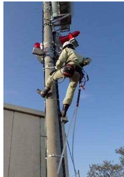
【写真2 作業状況】
