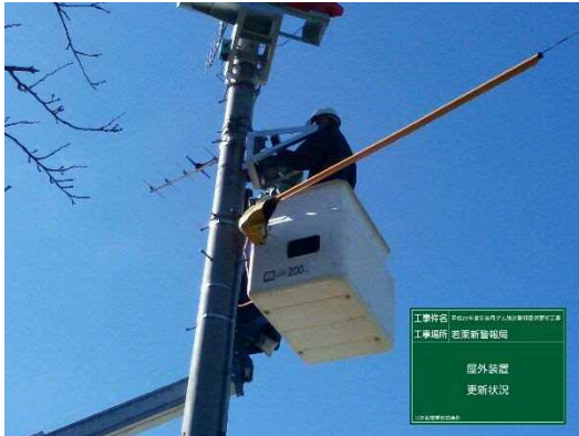
【写真8 屋外作業状況】
