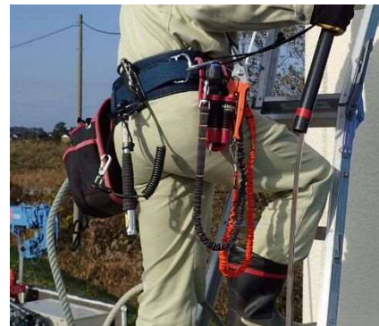
【写真3 落下防止ワイヤー取付状況】
