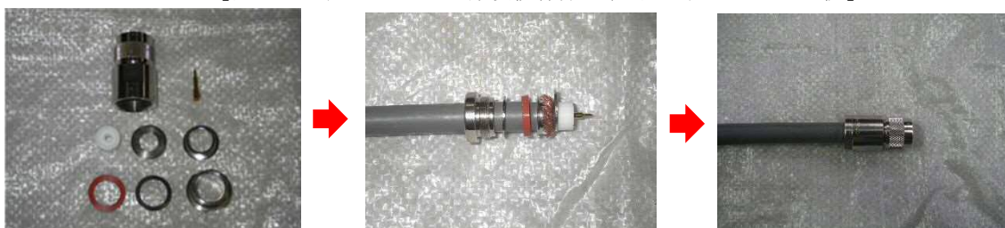
【写真7 同軸コネクタ取付の流れ】
