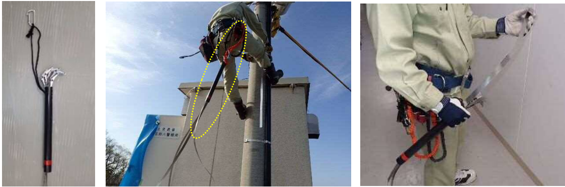
【写真6 ステンレスバンド入れを用いた運搬・取出方法】
