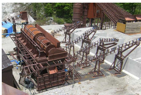
写真③-1 H27（春）確認状況 骨材製造設備
