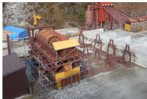
写真③-2 H28（冬）冬期防護完了
