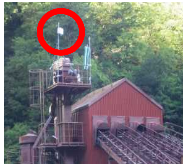
写真①-2 設置箇所（プラント上部）
