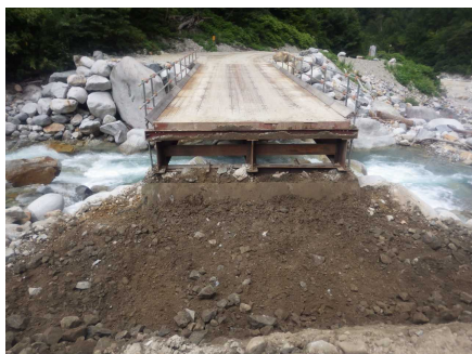
写真②-4 掘削完了
