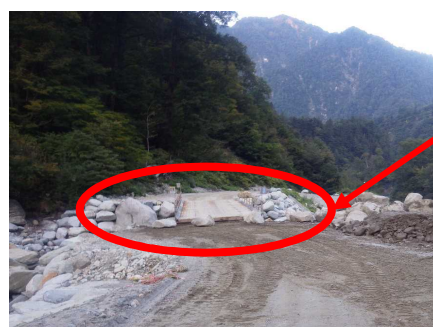
写真②-5 バイパス水路設置完
