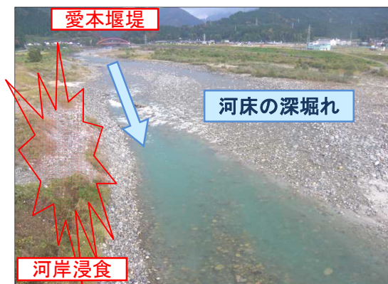
施工前の状況
