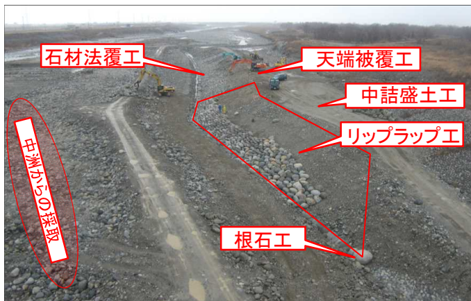
施工中の状況
