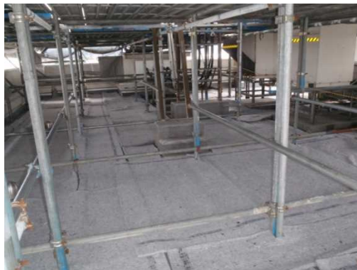
【 写真-3 吸出防止マット敷設 】
