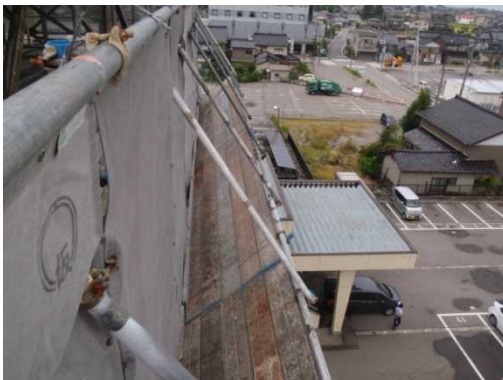
【 写真-2 張出し朝顔取付け 】
