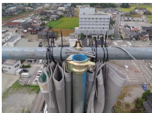
【 写真-8 飛散防止ネット上部固定状況 】 【 写真-9 飛散防止ネット収納訓練 】
