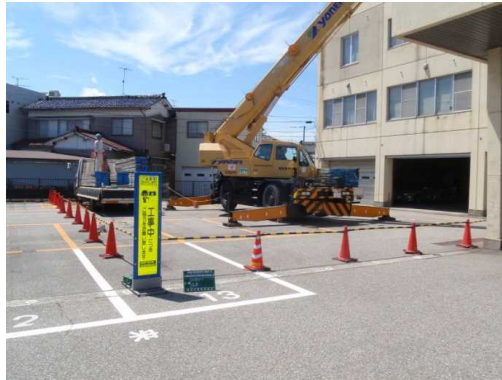
【 写真-1 レッカー作業時現場区画 】
