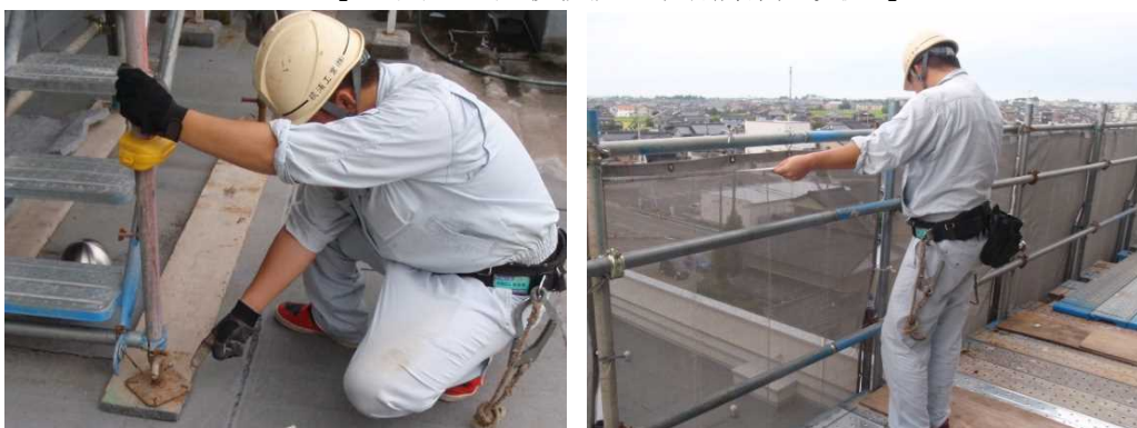
【 写真-5 強風後仮設足場各所確認状況 】
