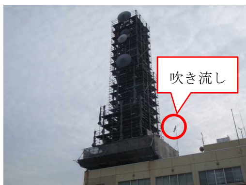
【 写真-6 仮設足場吹き流し取付状況 】 【 写真-7 デジタル風速計測定状況 】
