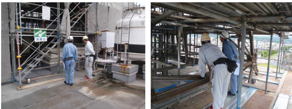
【 写真-4 労働基準監督署 仮設足場確認状況 】
