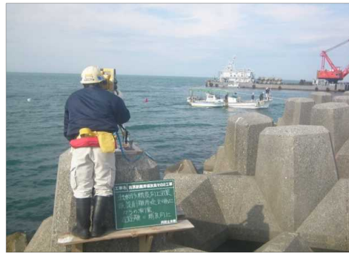
【写真(1)-3】 測量状況(安全帯使用)
