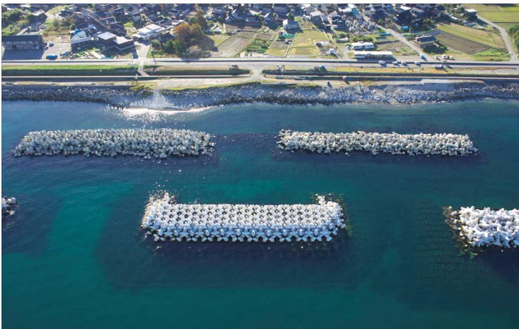
【写真4-2】 完成写真
