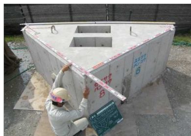
【写真(2)-5】 コンクリートブロック 製作寸法測定
