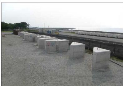
【写真(2)-4】 コンクリートブロック 製作完了全景
