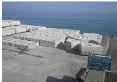
【写真(2)-7】 コンクリートブロック 岸壁運搬仮置き
