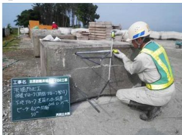
【写真(2)-1】 下地根固ブロック 用心鉄筋D16mm設置
