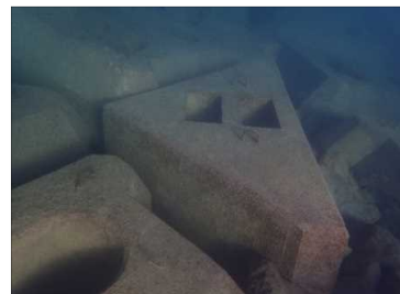
【写真(2)-9】 コンクリートブロック 据付(水中部)
