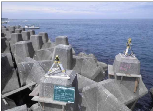
【写真(1)-2】 ブロック上での機械設置
