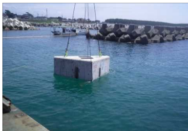
【写真(2)-8】 コンクリートブロック 海上据付
