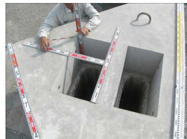
【写真(2)-6】 コンクリートブロック 浮力低減孔設置
