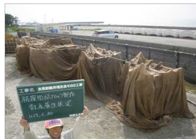
【写真(2)-3】 コンクリートブロック 散水養生状況
