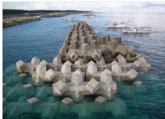
【写真(3)-5】現場での据付
