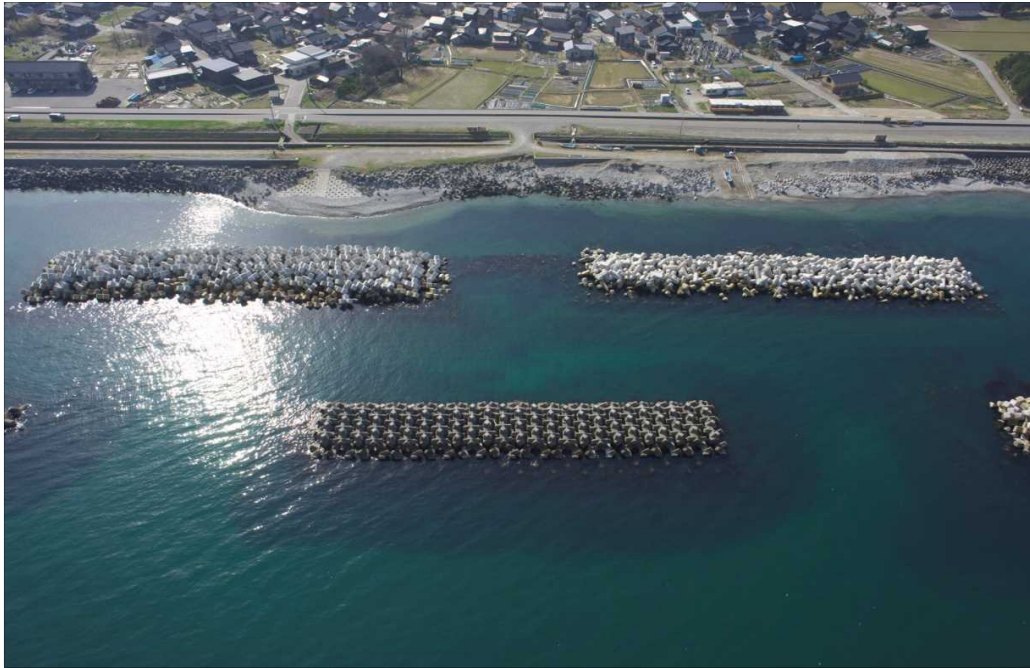
【写真4-1】 着工前写真
