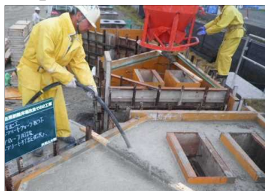
【写真(2)-2】 コンクリート打設状況
