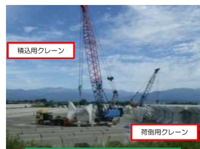
クローラークレーン2台による 本体ブロック運搬状況
