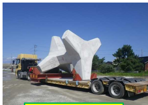
本体ブロック陸上運搬状況
