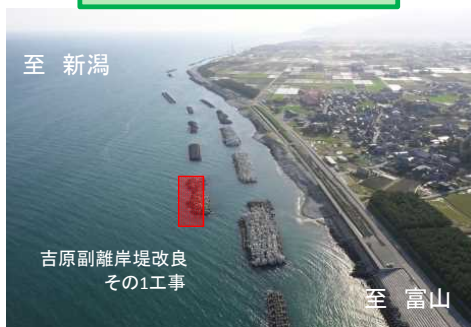
副離岸堤施工箇所
