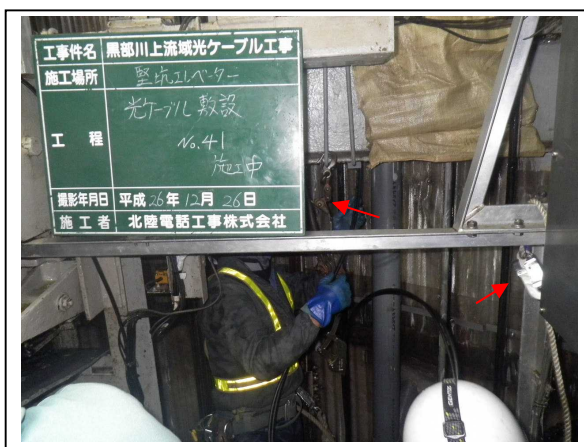
シメラーによるケーブル落下防止と、安全带フックの取付状況
