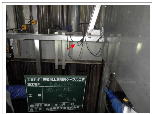
ラチェットの落下防止紐取付状況
