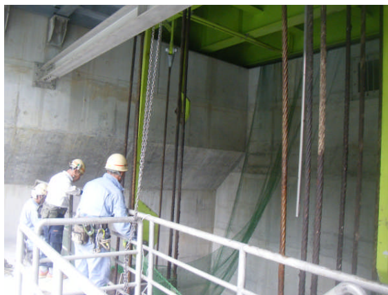
安全ネット設置状況
