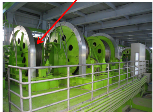
止水ゲート・戸溝保護枠開閉装置
