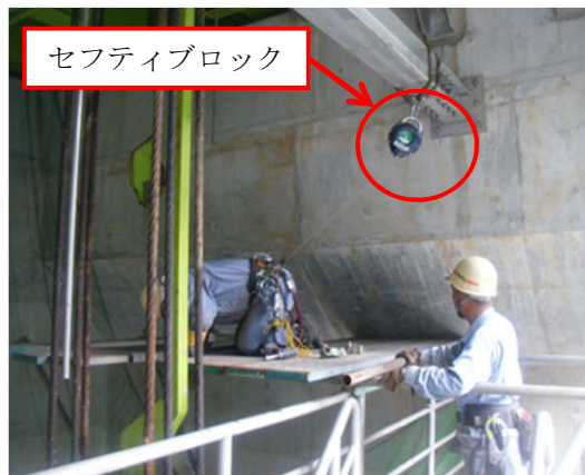
セフティブロック使用状況
