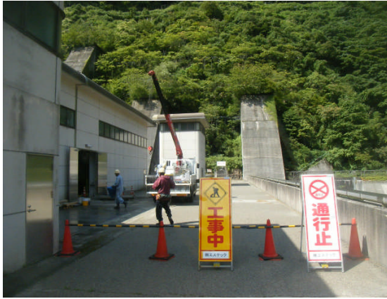
資機材搬入時
