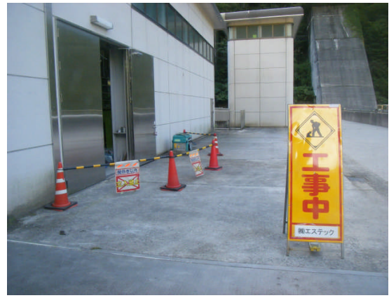
開閉装置室出入り口
