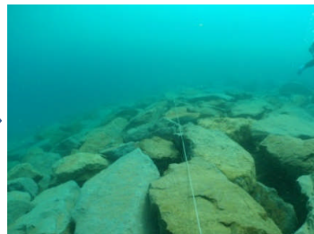
捨石荒均し(±30cm)完了
