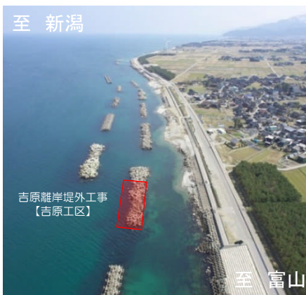
【 離岸堤施工箇所(吉原地先) 】
