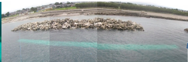
吸出し防止マット敷設完了
