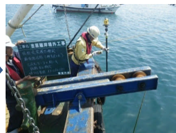
ブロック設置位置測量
