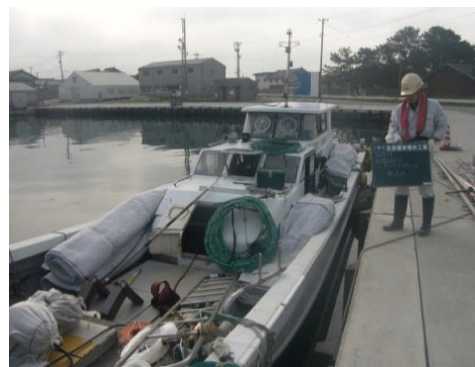
【吸出し防止マット積込完了】
