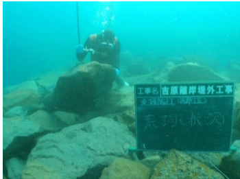
捨石荒均し(±30cm)状況
