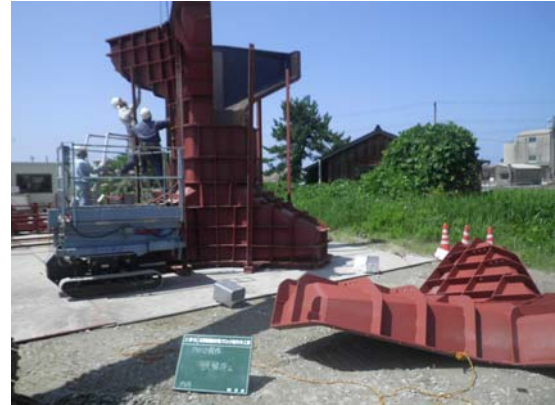
型枠 試験施工
