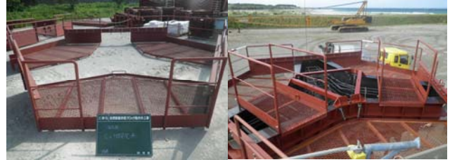
鋼材使用 足場 (ユニット型)
