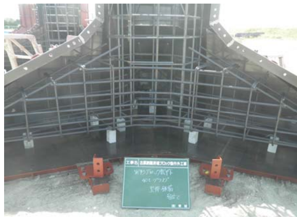
スペーサー 設置状況
