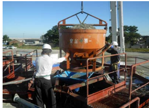
コンクリート打設状況
