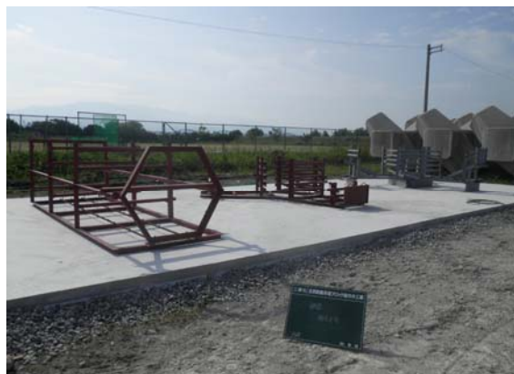
組立架台 設置状況
