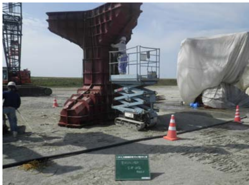
高所作業車による作業状況
