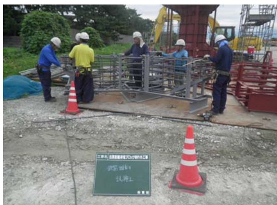
配筋 試験施工
