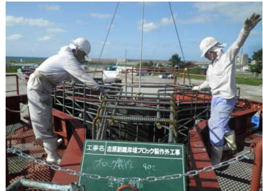
鉄筋配置状況
