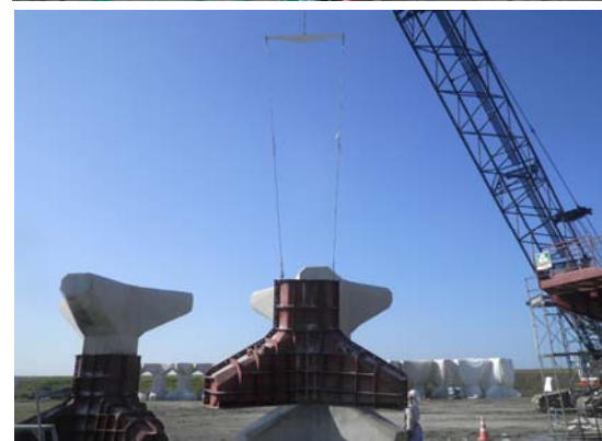
脱枠作業状況
