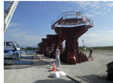
専用足場 設置状況
