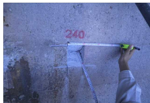
写真-4 切欠き完了近景
