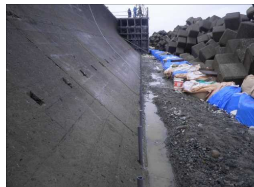
写真-12 注入管配置精度(目視確認)
