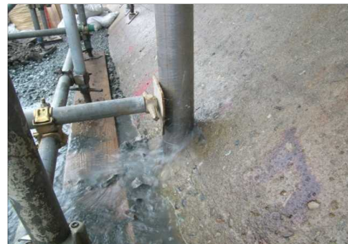
写真-6 削孔状況
