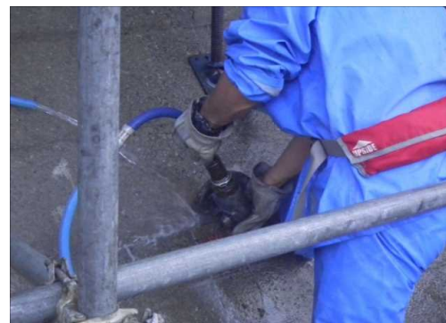
写真-2 コンクリート切り欠き状況
