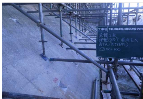
写真-3 切欠き完了全景
