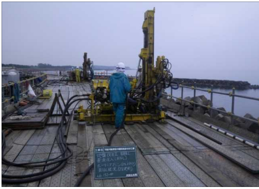
写真-7 削孔状況全景
