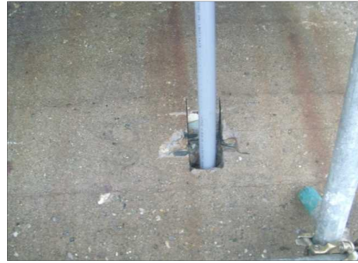
写真-8 注入管設置完了
