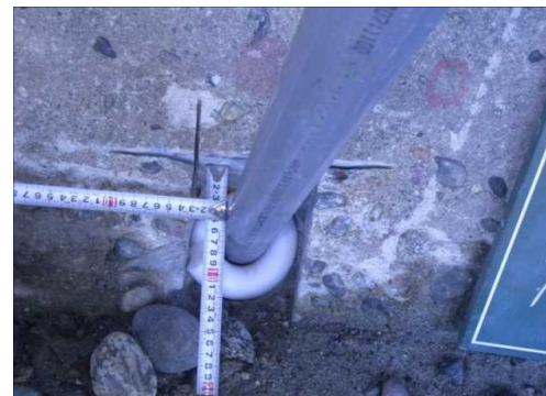
写真-10 バックアップ材φ36設置
