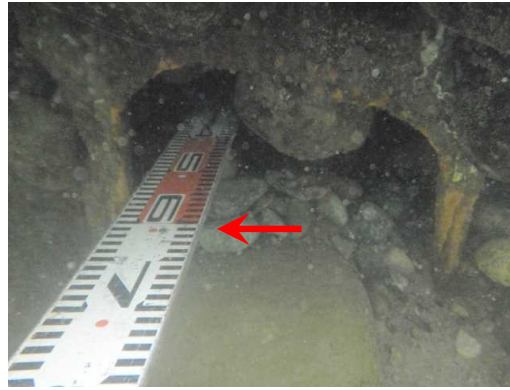
写真1. 鋼矢板 損傷状況
