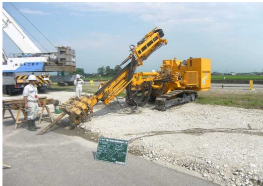
写真2. 空洞調査状況
