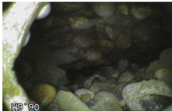
写真3. カメラによる空洞確認
