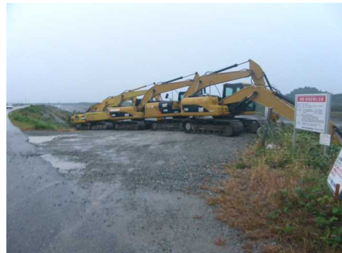
図4-9 増水時重機退避状況
