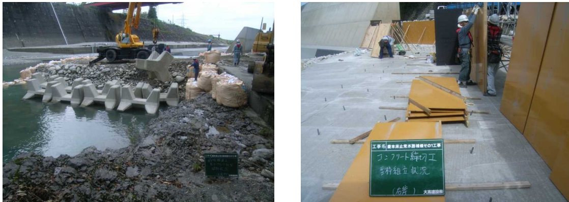
図4-7 ライフジャケット着用作業状況
