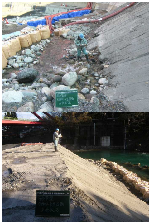
図4-11 仮締切点検状況
