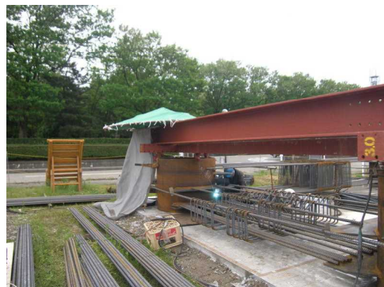
山留材設置状況 写真③
