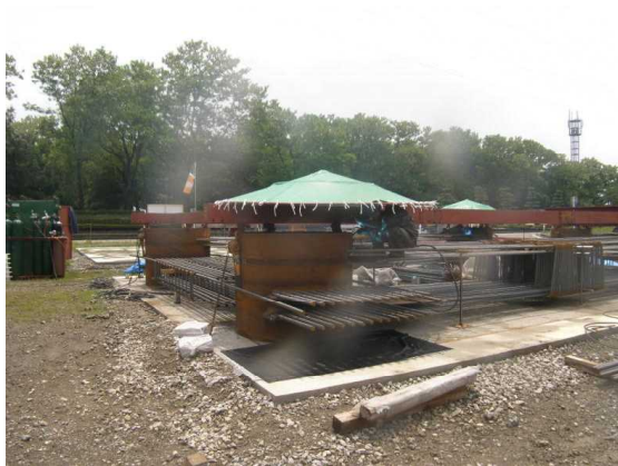
鉄筋溶接時固定状況 写真⑥
