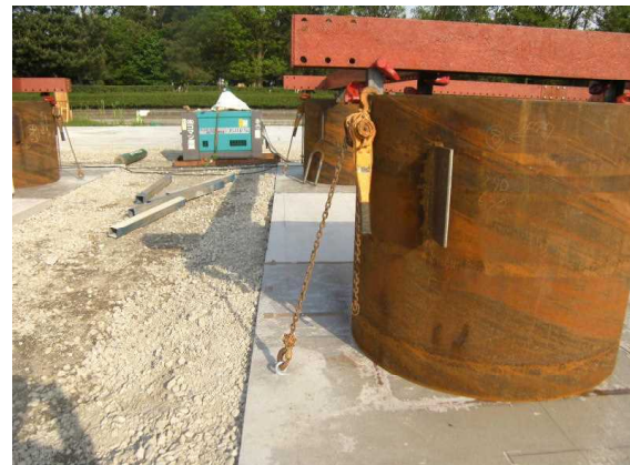
レバーブロックによる固定 写真⑦
