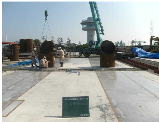
ガイド管据え付け状況 写真①
