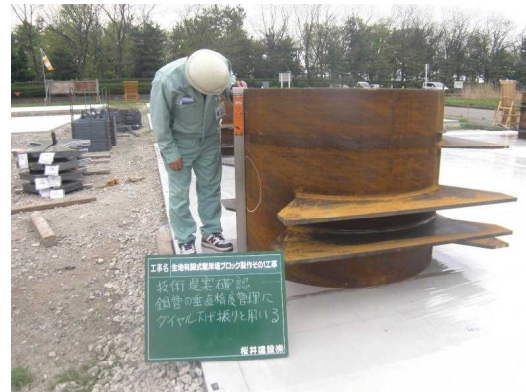
ダイヤル下げ振り使用状況 写真⑤
