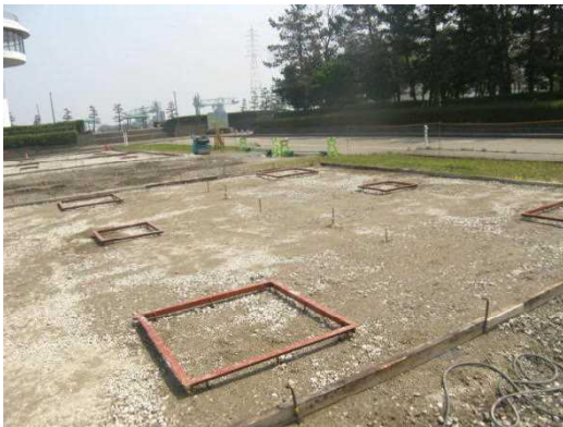
ガイド管受け枠設置状況 写真④
