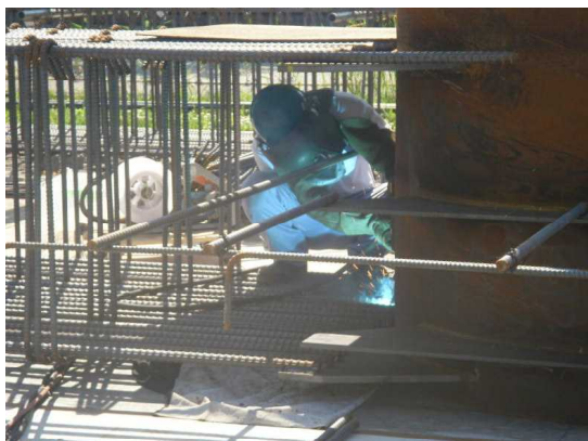
鉄筋溶接状況 写真②
