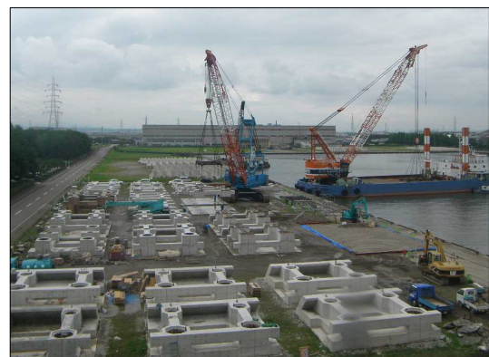
450t吊クローラクレーンによる陸上運搬状況
