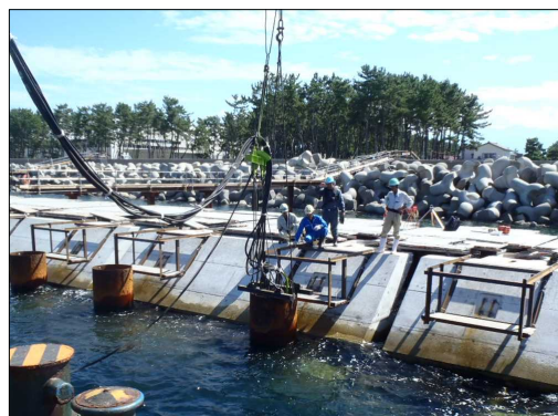
間詰工足場および鋼管仮設杭足場の設置状況
