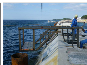
間詰工足場(写真左)と鋼管仮設杭足場のユニット化
