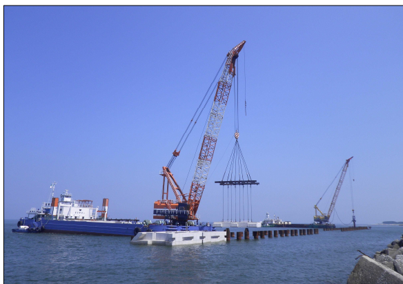
スパッド式起重機船によるブロック据付状況 (写真奥は越湖工区の鋼管杭打設)
