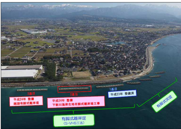
下新川海岸(生地沖)の離岸堤整備
