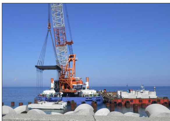
起重機船と台船の運搬による据付状況（6個/日）
