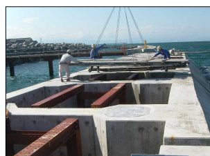
間詰工足場(写真左)と鋼管仮設杭足場のユニット化
