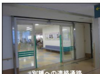
別棟への連絡通路 止水板のための角としての設置
