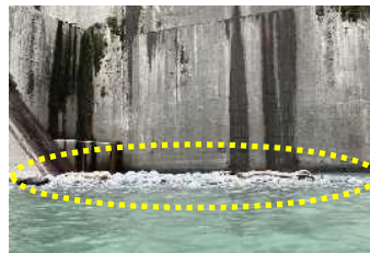
宇奈月ダム直下で土砂堆積を確認(通砂後)
