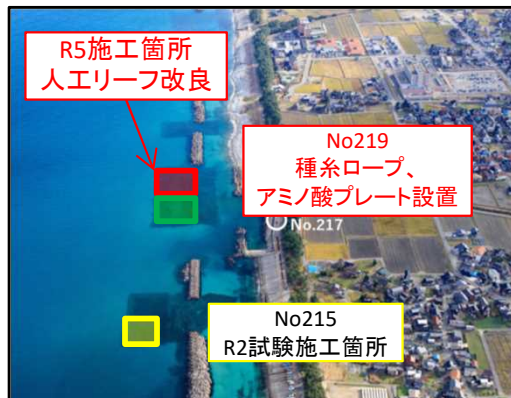
朝日町赤川地先 (1工区)
