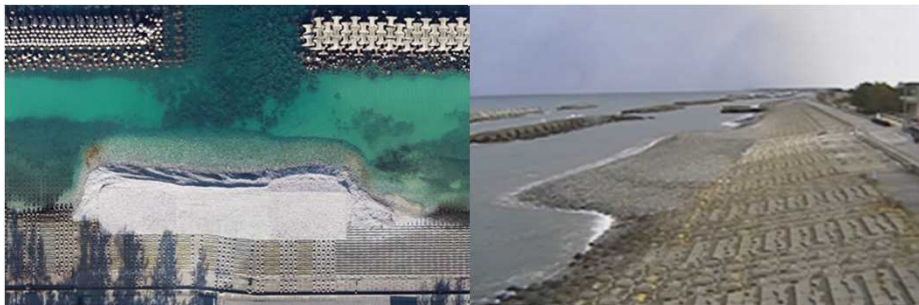
試験養浜の状況(令和2年12月時点)
