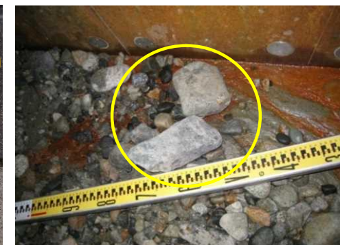
排砂路内に20cm内外の礫材が確認 (H24排砂路調査)
