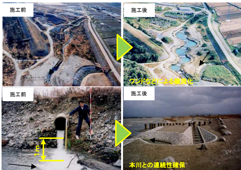
施工例(上:浦山、下:村椿)
