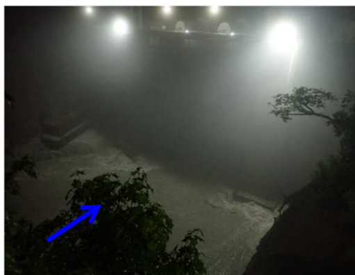
【出し平ダム排砂路呑口部】自然流下開始時(EL.306.34m) 7月13日 22:00撮影
