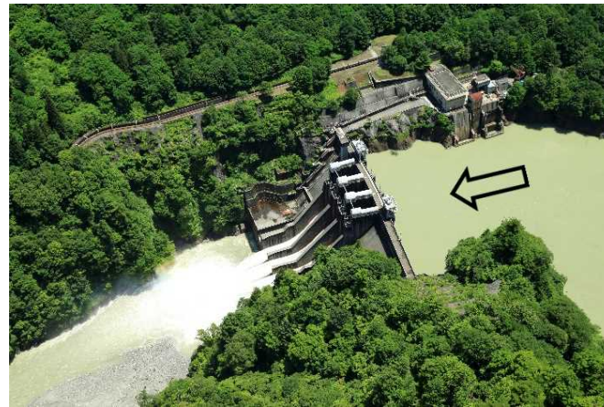
出し平ダム(左岸より望む)
