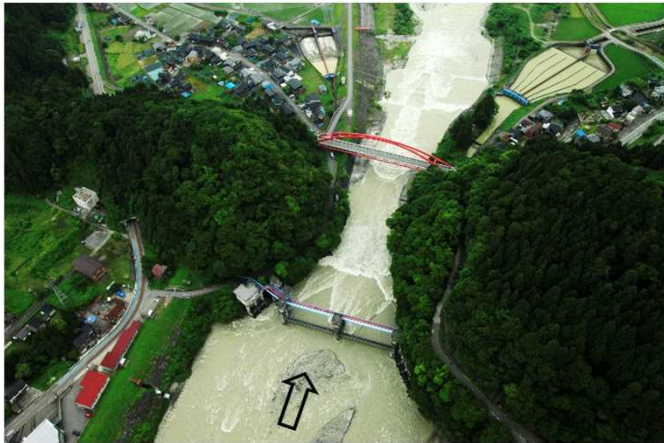
愛本合口堰堤(河口より13.5km)
