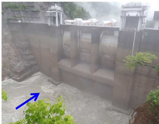
【出し平ダム排砂路呑口部】自然流下開始時(EL.307.44m) 7月1日 13:24撮影
