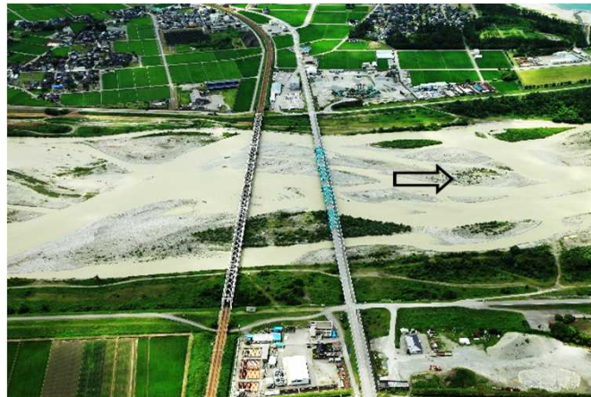
下黒部橋(河口より0.8km)
