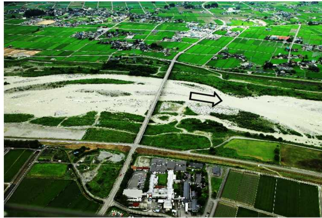
新川黒部橋(河口より9.6km)
