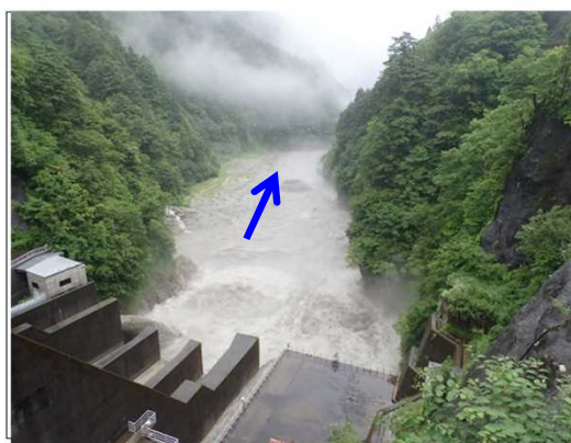
【出し平ダム下流】自然流下開始時(EL.307.44m) 7月1日 13:24撮影
