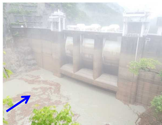
【出し平ダム排砂路呑口部】水位低下中(EL.316.00m) 7月1日 09:35撮影
