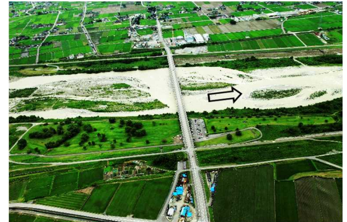
権蔵橋(河口より8.2km)
