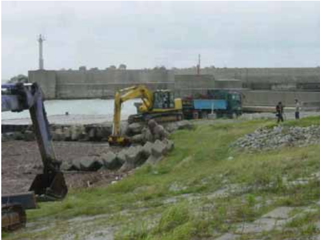
7月20日右岸河口流木撤去状況
