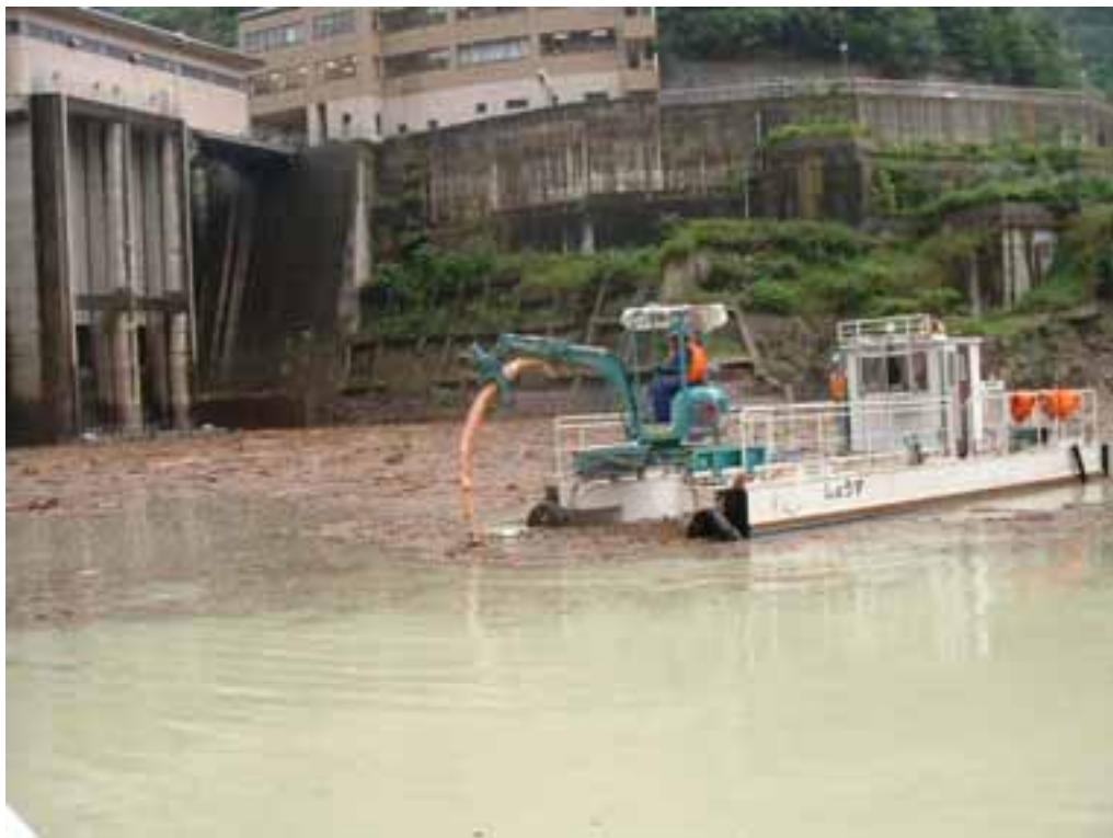
7月20日ダム湖内流木撤去状況
