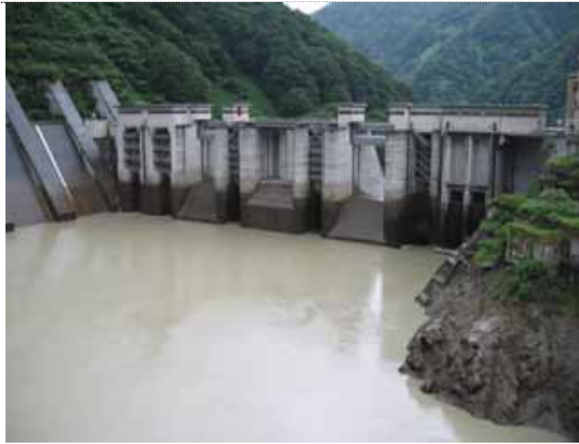
②13:59撮影 宇奈月ダム背面状況
