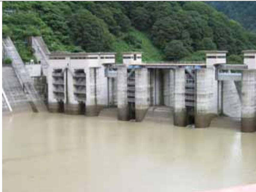
【常用洪水吐ゲート及び水位低下用ゲートによる放流】 【流木の固まりはダム本体周辺で確認されず】
