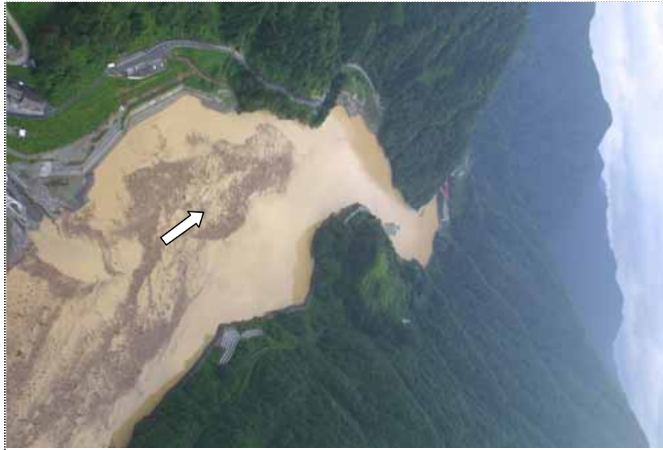
①6:16撮影 ヘリ空撮宇奈月ダム貯水池の状況
