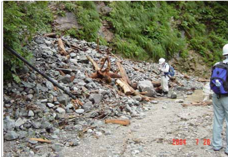
7月26日 撮影祖母谷工事用道路
