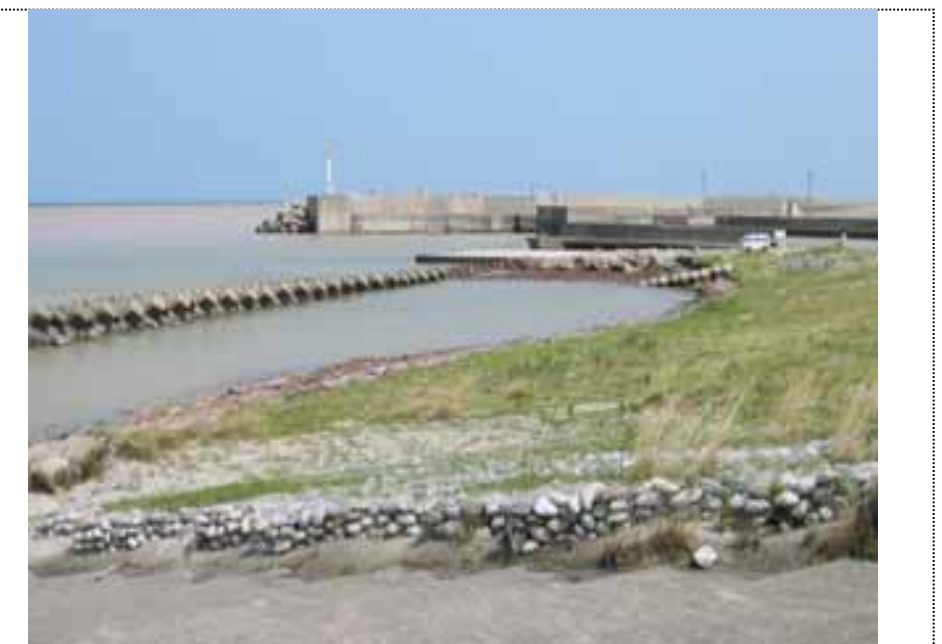
⑥9:58撮影 黒部川右岸河口から入善漁港を望む
