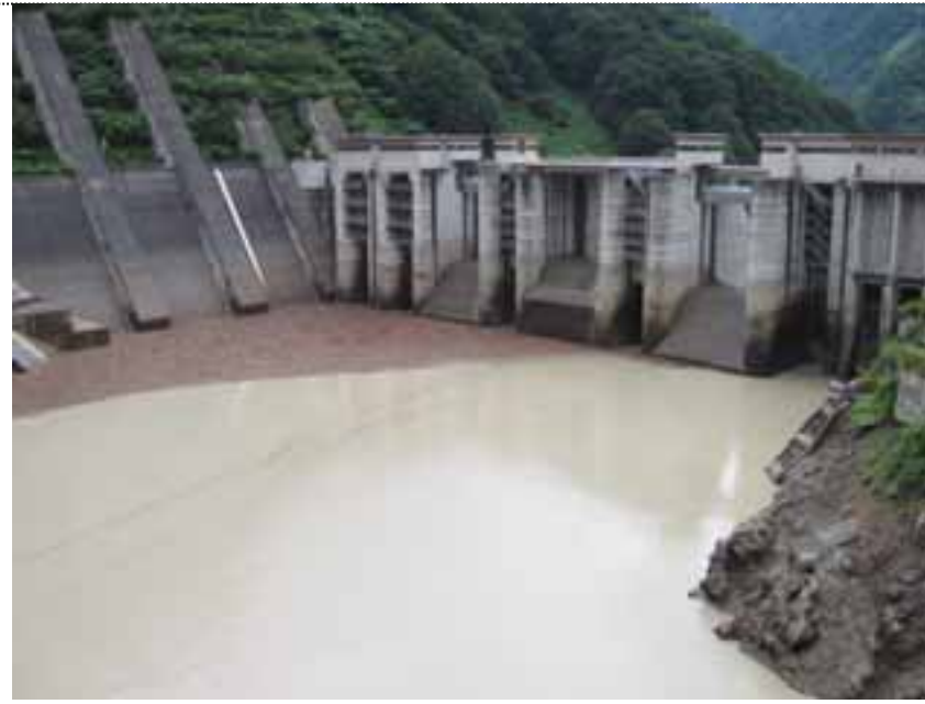
①8:53撮影 宇奈月ダム背面状況
