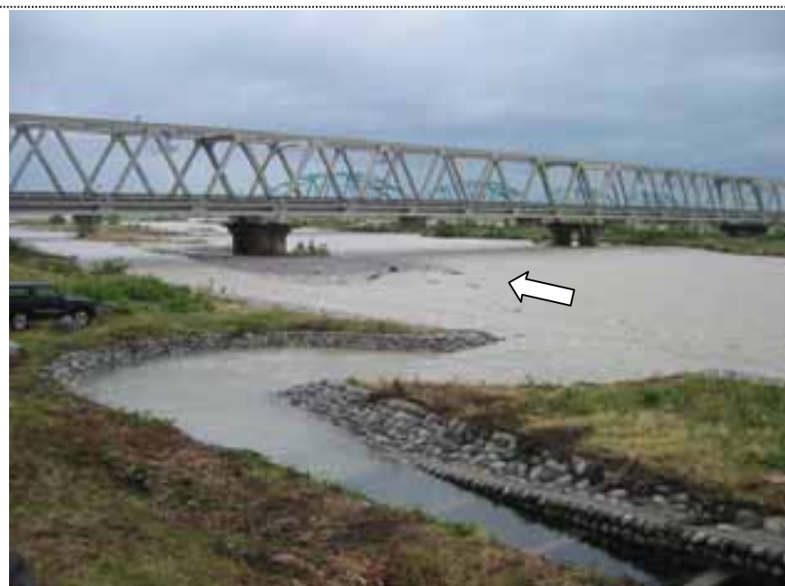
⑤15:35撮影 飛騨魚道 高水敷から下流JR橋を望む
