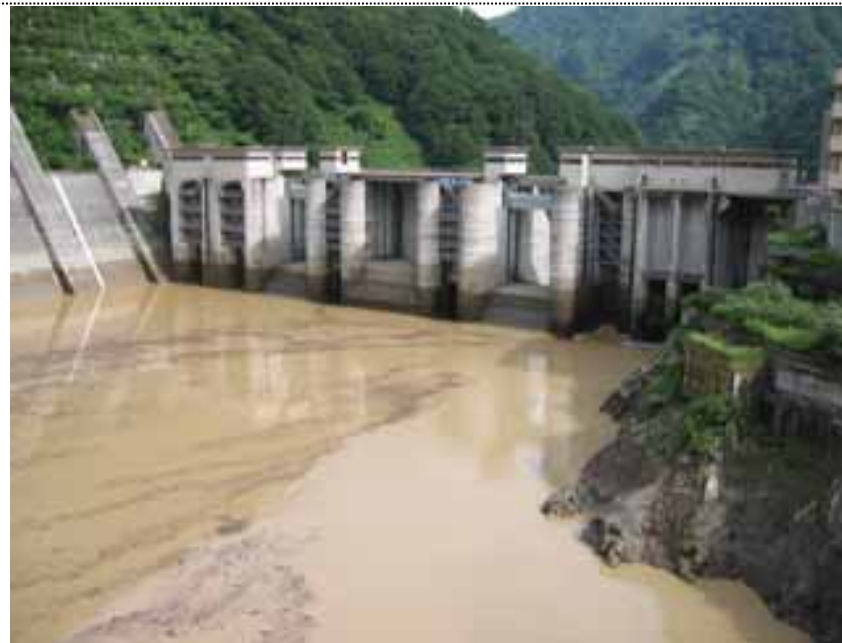
②8:25撮影 宇奈月ダム背面状況
