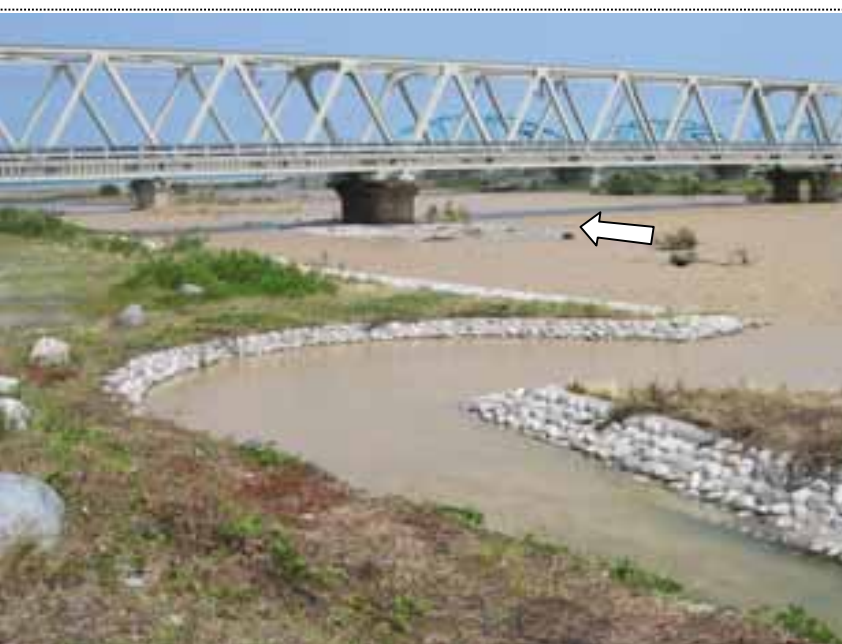
⑤10:18撮影 飛騨魚道 高水敷から下流JR橋を望む
