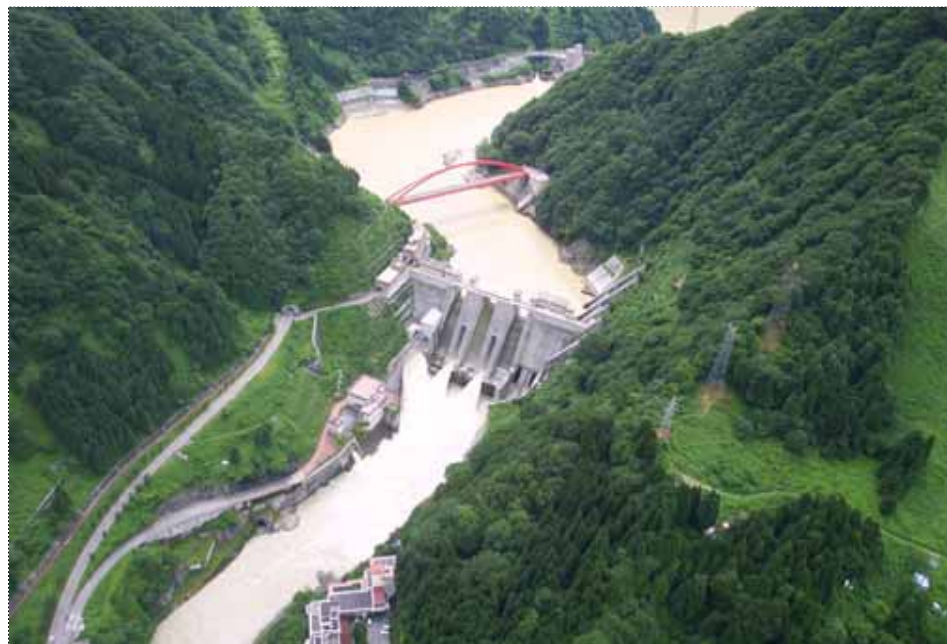
【常用洪水吐ゲート及び水位低下用ゲートによる放流】 【貯水池に流木の固まりは確認されず】
