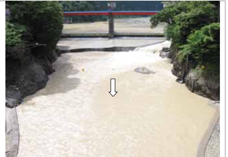
③9:25撮影 愛本橋から上流愛本堰堤を望む
