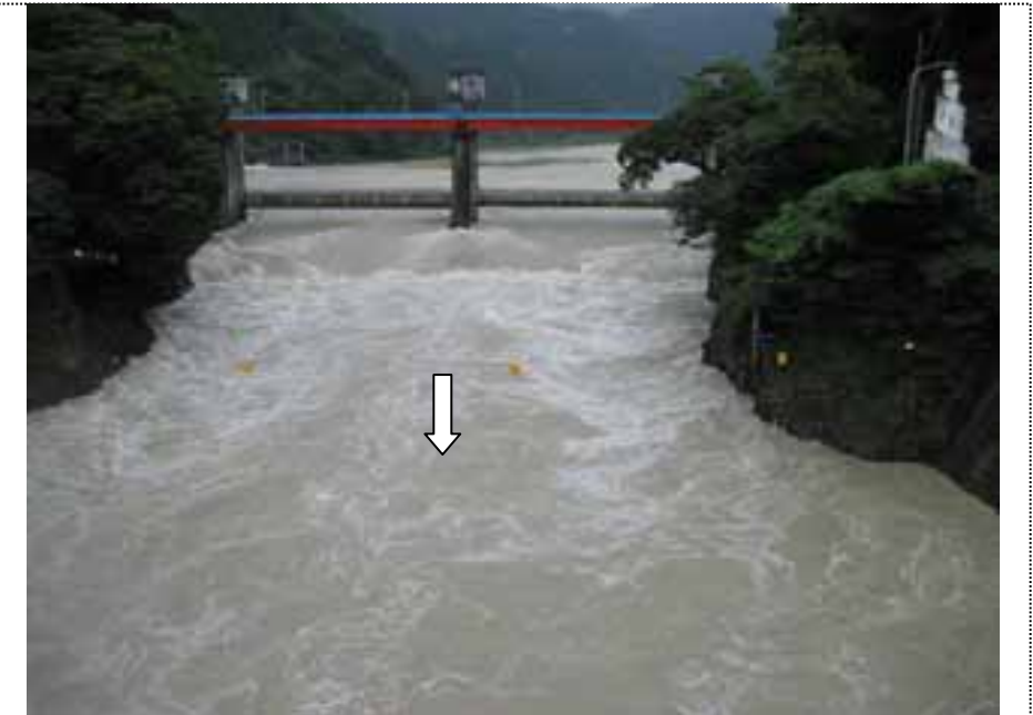
③14:26撮影 愛本橋から上流愛本堰堤を望む
