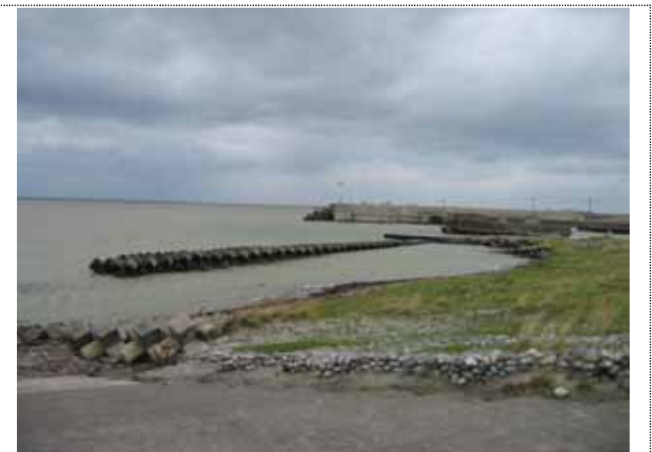
⑥15:16撮影 黒部川右岸河口から入善漁港を望む
