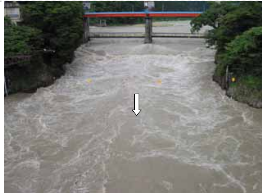
【下流愛本地点流量9:20 496m 3 /s】 【流木は確認されず】
