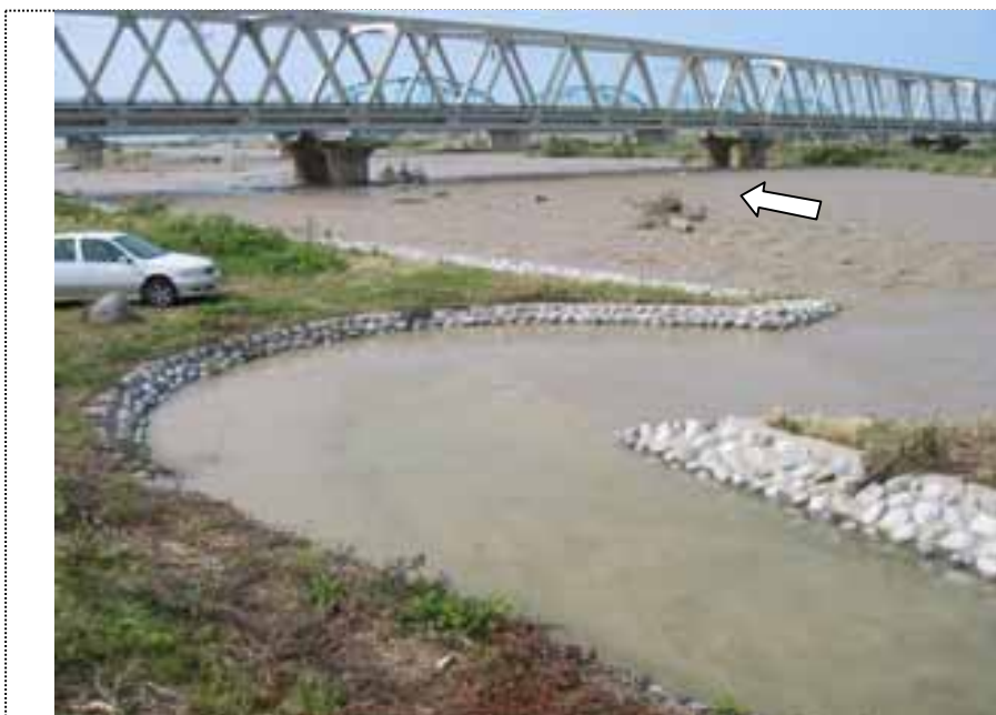
⑤15:08撮影 飛騨魚道 高水敷から下流JR橋を望む
