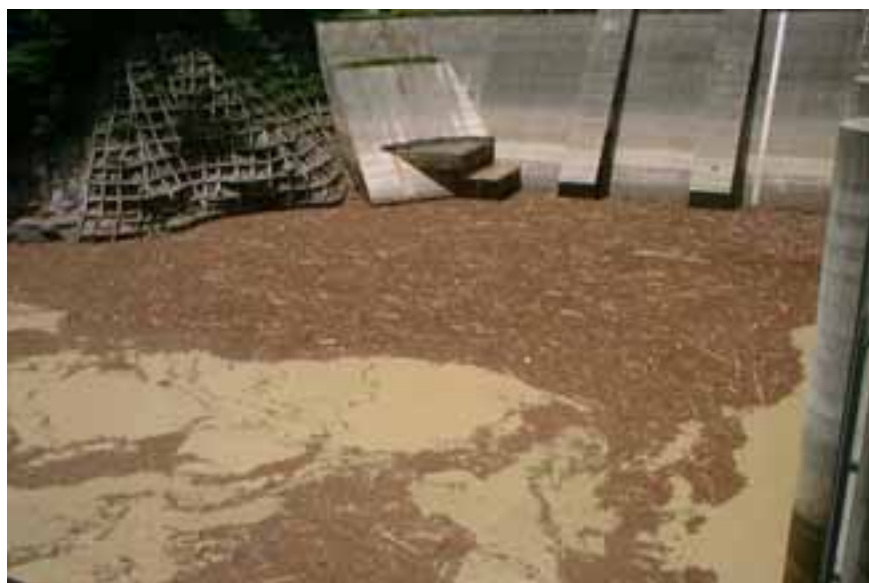
ダム湖内に貯留された流木の状況
