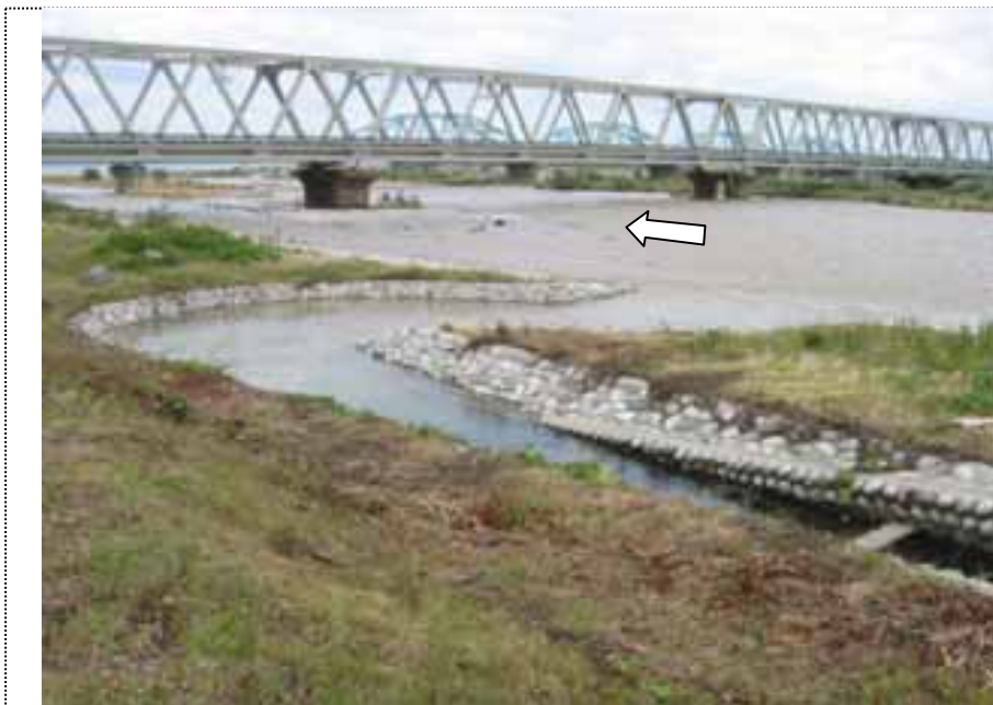
【上流愛本地点流量10:50 520m 3 /s】 【流木は確認されず】
