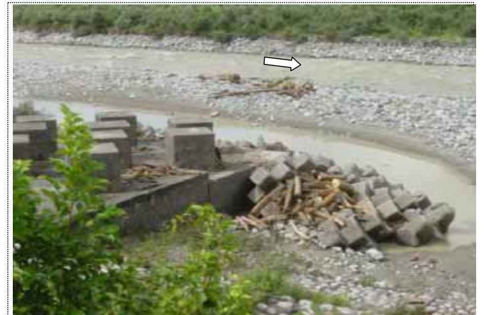
7月19日 15:04撮影 左岸下立地先(11.8km)水制
