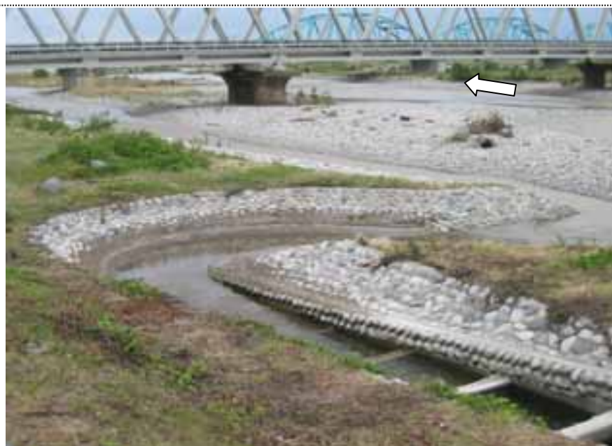
⑤10:39撮影 飛騨魚道 高水敷から下流JR橋を望む
