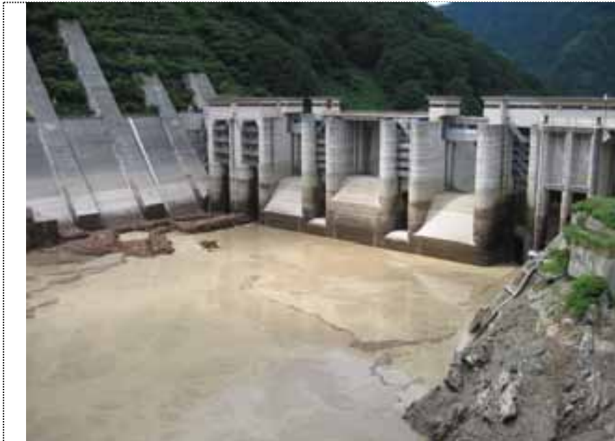
②13:16撮影 宇奈月ダム背面状況
