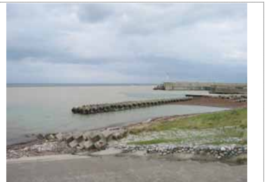
⑥10:32撮影 黒部川右岸河口から入善漁港を望む
