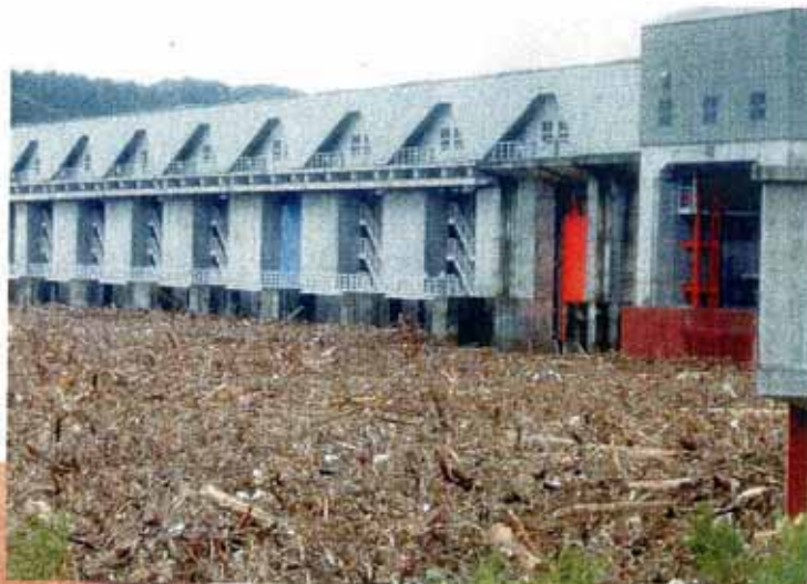
湖面を埋め尽くす流木 (写真提供/宮崎開発建設部)
