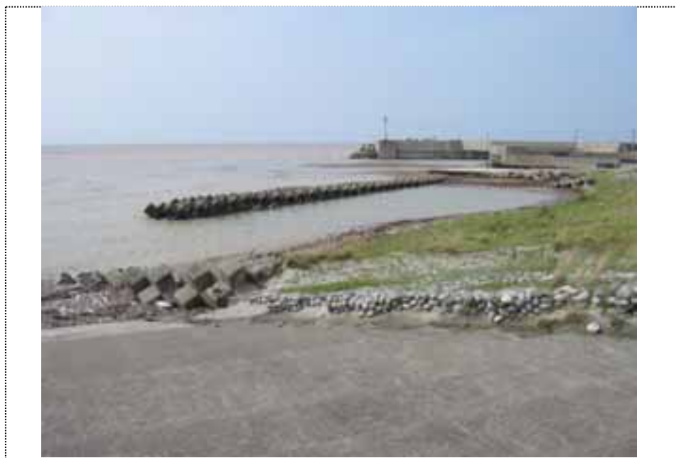
⑥14:45撮影 黒部川右岸河口から入善漁港を望む
