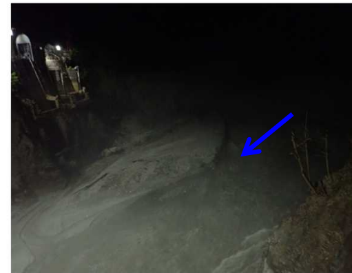
【出し平ダム湛水池】自然流下完了(EL.305.25m) 7月14日 01:00撮影
