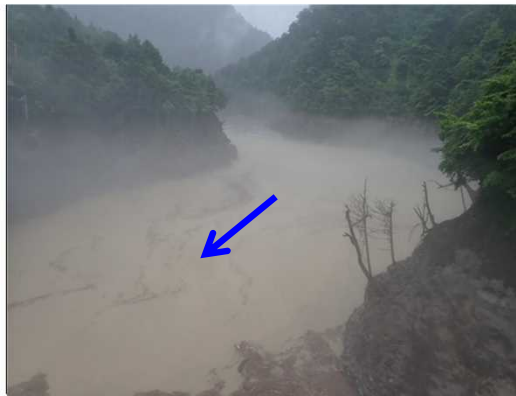
【出し平ダム湛水池】水位低下中(EL.316.55m) 7月13日 17:05撮影
