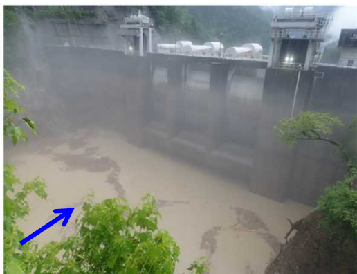
【出し平ダム排砂路呑口部】水位低下中(EL.316.55m) 7月13日 17:05撮影
