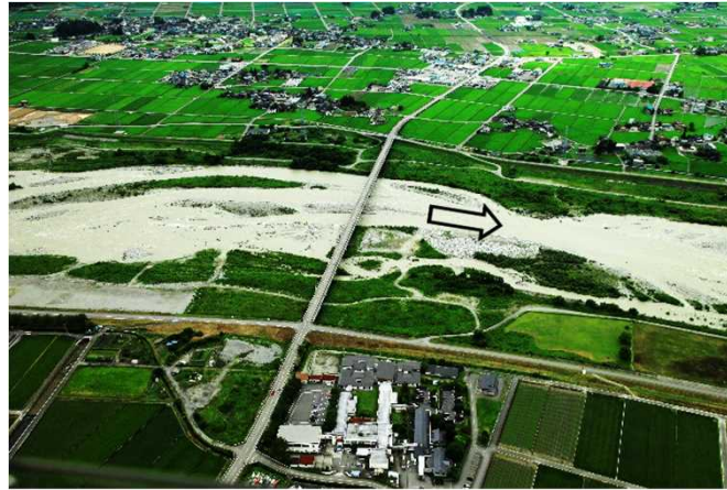
新川黒部橋(河口より9.6km)
