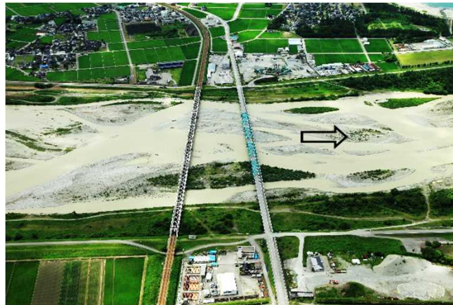
下黒部橋(河口より0.8km)
