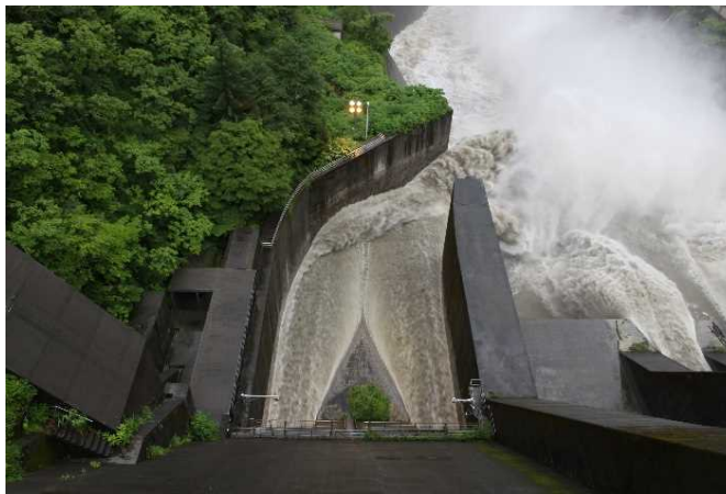
排砂ゲート開操作30分後 【7月1日6時00分】
