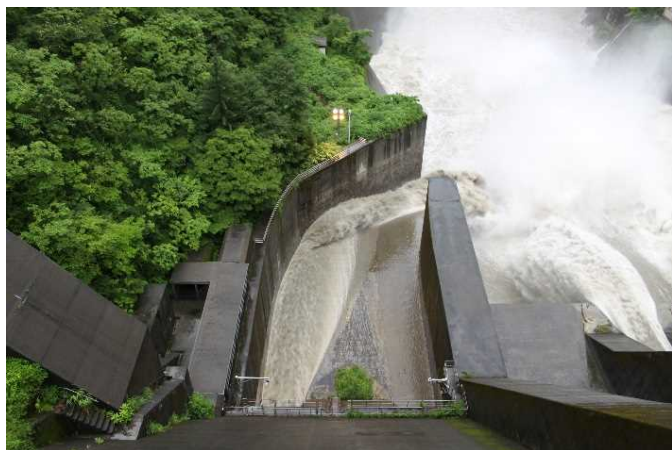
排砂ゲート開操作10分後 【7月1日5時40分】
