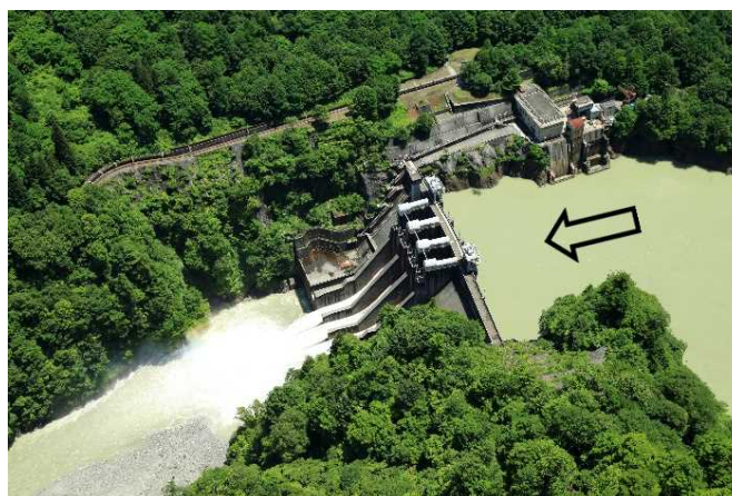
出し平ダム(左岸より望む)
