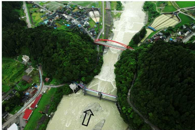
愛本合口堰堤(河口より13.5km)
