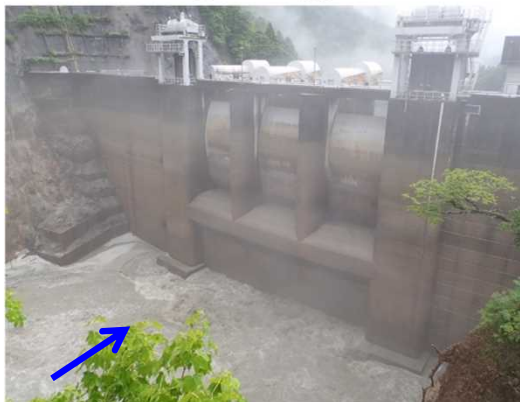
【出し平ダム排砂路呑口部】自然流下開始時(EL.307.44m) 7月1日 13:24撮影
