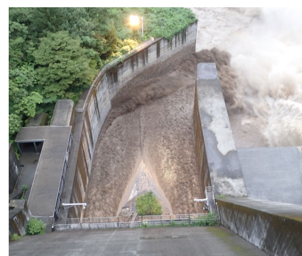
排砂ゲート開操作30分後 【8月21日5時40分】
