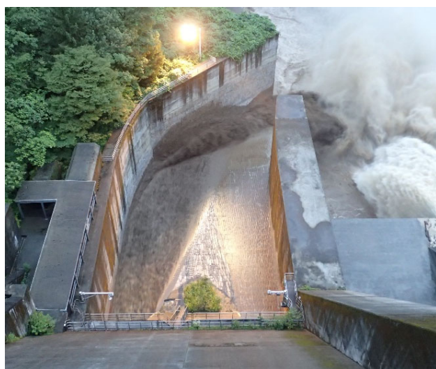
排砂ゲート開操作10分後 【8月21日5時20分】
