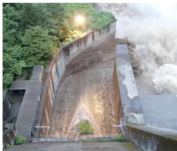
排砂ゲート開操作20分後 【8月21日5時30分】
