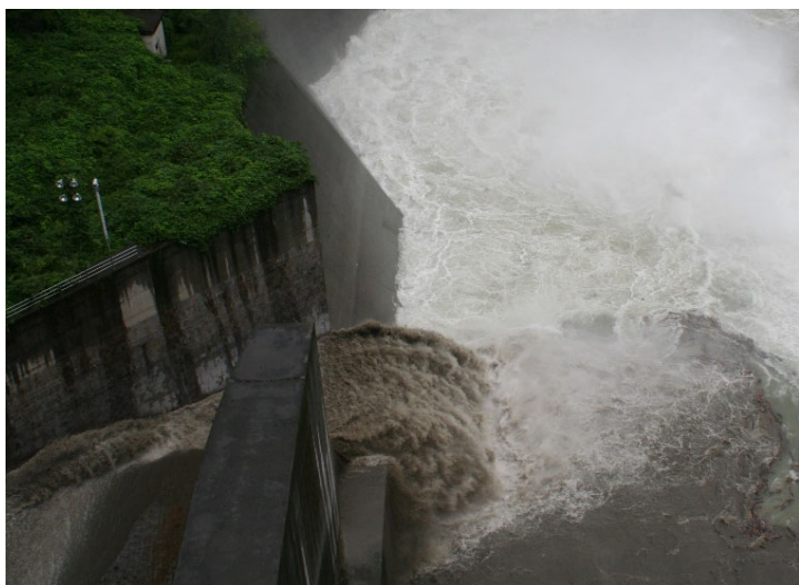
排砂ゲート開操作5分後 【9月1日14時55分】
