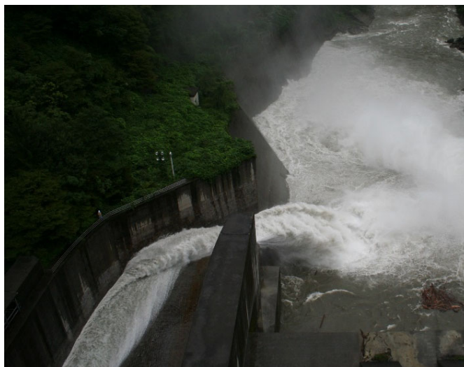
排砂ゲート開操作10分後 【9月1日15時00分】
