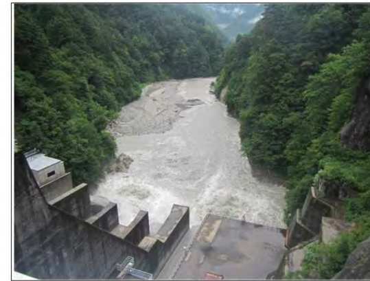
【出し平ダム下流】自然流下完了(EL.305.40m) 7月1日 6:30撮影
