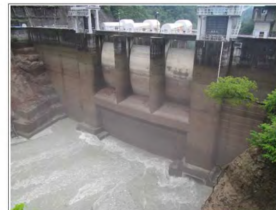
【出し平ダム排砂路呑み口部】自然流下完了(EL.305.40m) 7月1日 6:30撮影
