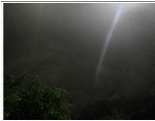
【出し平ダム排砂路呑み口部】自然流下中(EL.307.14m) 7月1日 0:10撮影
