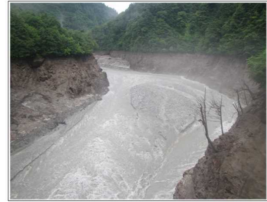
【出し平ダム湛水池】自然流下完了(EL.305.40m) 7月1日 6:30撮影
