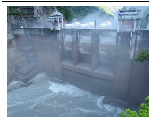
【出し平ダム排砂路呑み口部】 自然流下中
