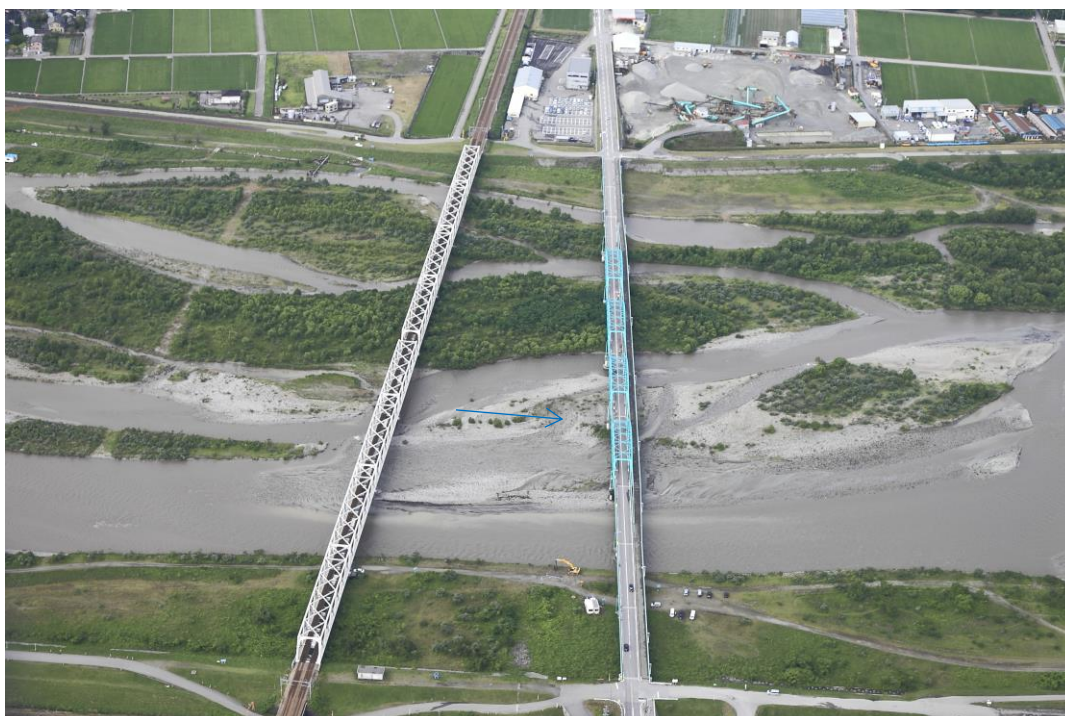
・ 下黒部橋（平成 28 年度連携排砂時：平成 28 年 6 月 26 日 7 時 35 分）
