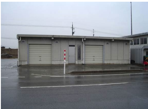
(ヘ) 右岸5.4k 上飯野水防倉庫(入善町)
