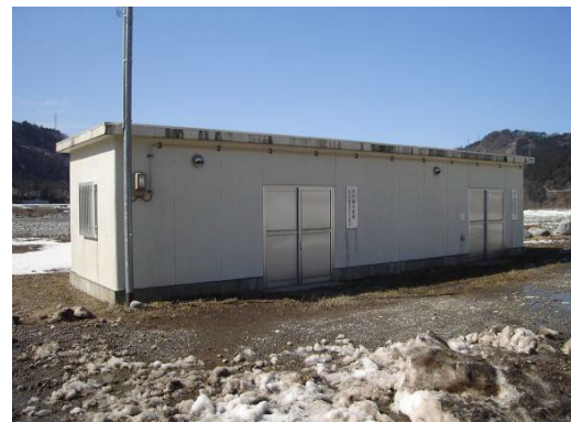
(ル)右岸15.5k 音沢堤緊急資材庫(国土交通省)
