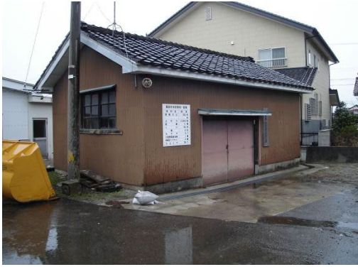
(子)前沢水防倉庫(黒部市)
