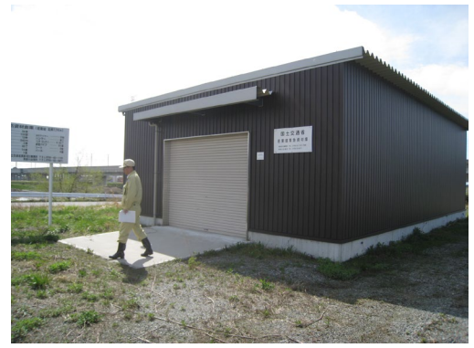
(ハ) 左岸7.5k 若栗堤緊急資材庫(国土交通省)
