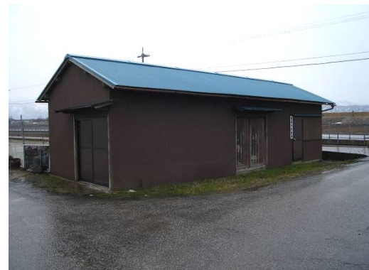
(ト) 右岸6.4k 福島水防倉庫(入善町)
