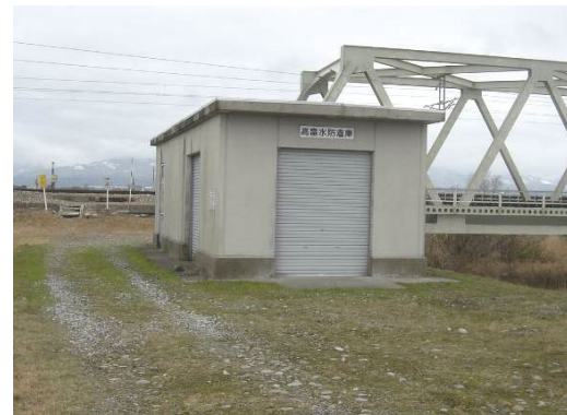
(ホ) 右岸0.6k 高畠水防倉庫(入善町)
