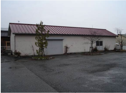
県道150号 黒部流域治水出張所
