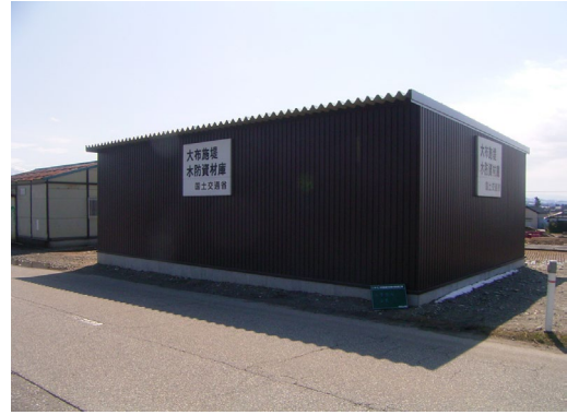
(イ) 左岸4.2k 大布施堤緊急資材庫(国土交通省)
