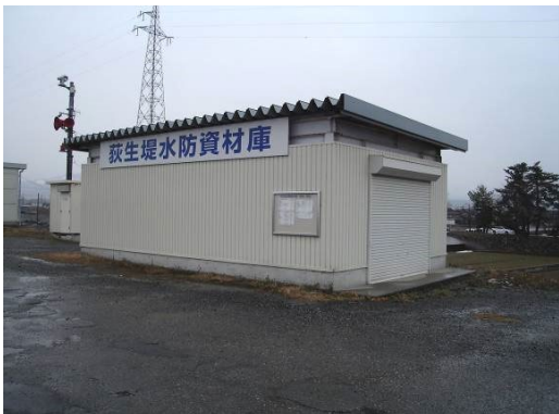
(ロ) 左岸4.3k 荻生堤緊急資材庫(国土交通省)
