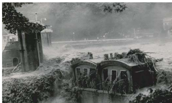
愛本堰堤被災状況
