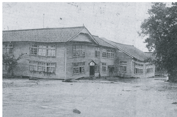
氾濫流により傾いた校舎（昭和9年）
