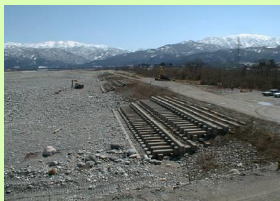
黒部川独自工法の堤防保護工（縦工）
