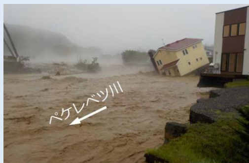
平成28年8月河岸洗掘による被害 (北海道十勝川水系) -国土交通省資料-
