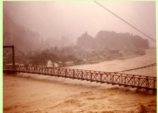
昭和44年8月洪水時の旧音沢橋付近の状況
