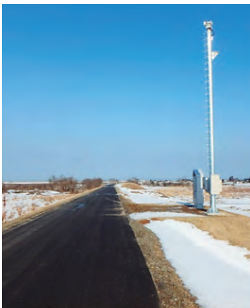
監視カメラの整備
