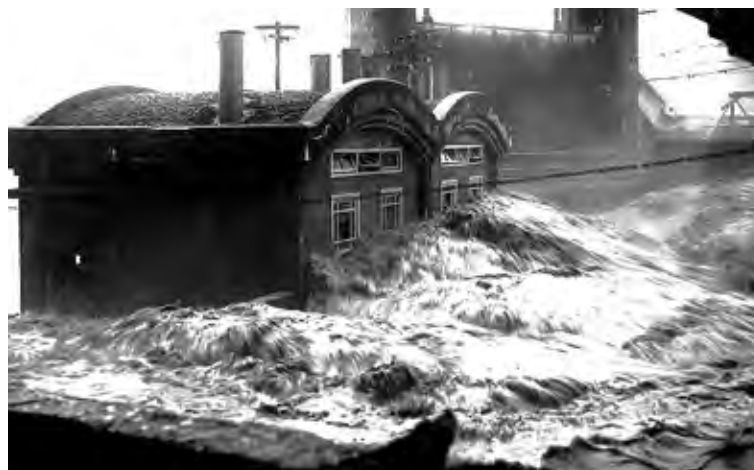
あいもとえんていかんりとう 愛本堰堤管理棟より 吹き出す流水
