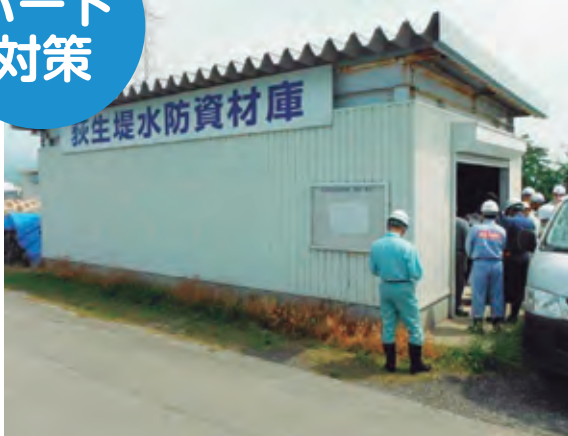
すいぼうしきざい はいび 水防資機材の配備
