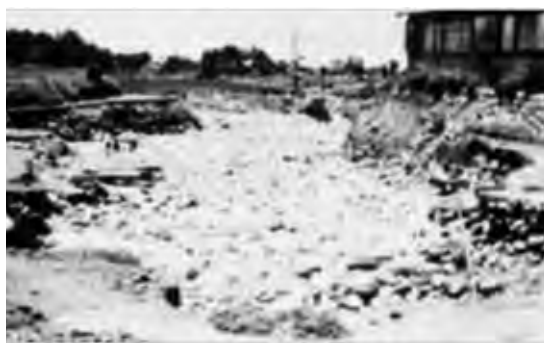
おぎゅうひさいしやうきやう 黒部市荻生被災状況
