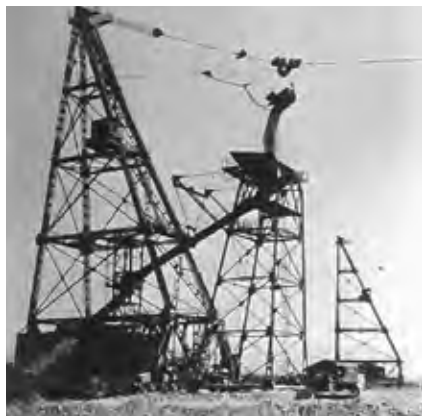
縦工 (平成3年度～) タワーエクスキャベーター
