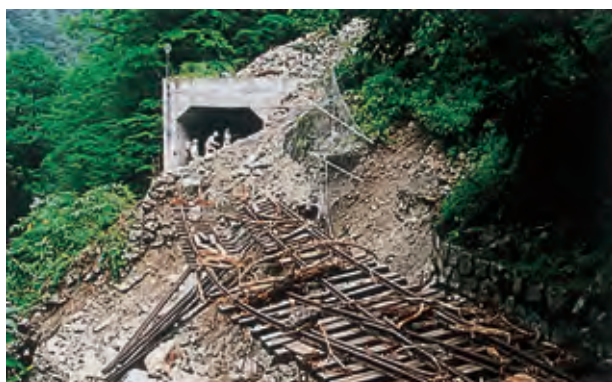
黒部峡谷鉄道黒薙引込み線の被災状況
