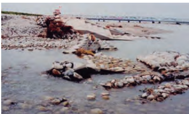
河岸侵食等により被災した護岸
