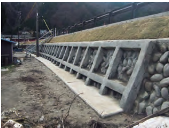
ていぼううらのりじり 堤防裏法尻の補強
