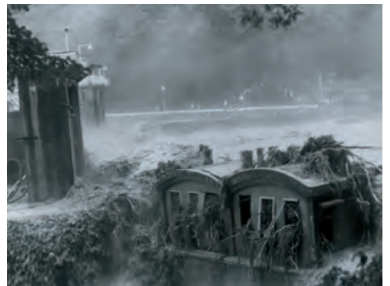
②激しい流れに耐える旧愛本堰堤
