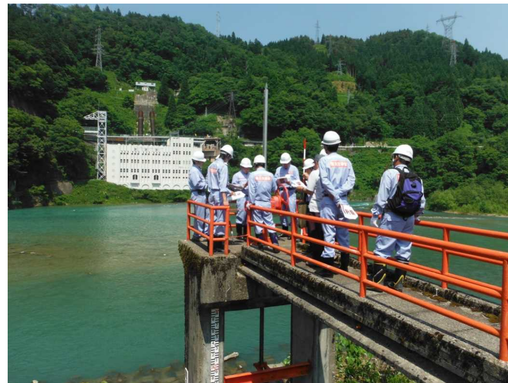
平成27年6月1日(月):水閘門の操作(電気・手動)訓練を実施 (赤田排水樋管)
