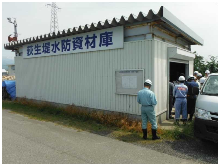
平成27年6月11日(木):水防団と自治体との水防資機材の確認 (荻生堤水防資材庫)
