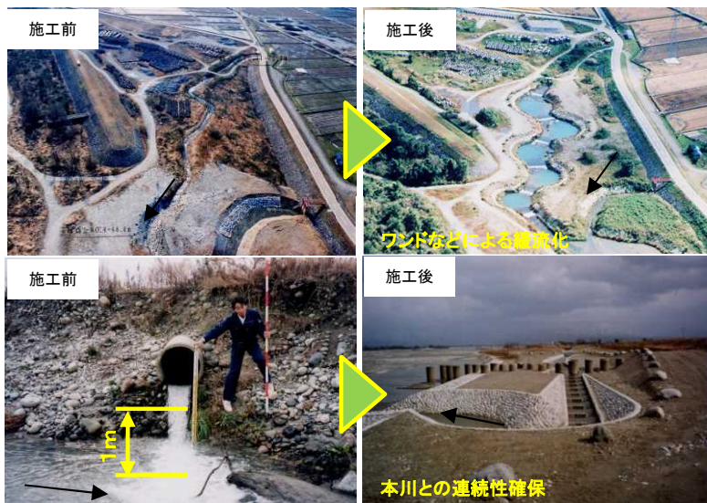
施工例(上:浦山、下:村椿)
