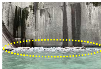
宇奈月ダム直下で土砂堆積を確認(通砂後)
